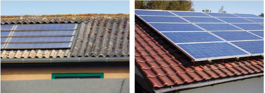
**Abb. 3.5: PV-Module bei geneigten Dächern. Links: Indach-Montage. Rechts: Aufdach-Montage**
