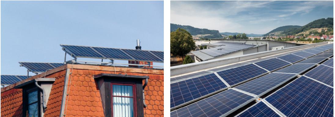
**Abb. 3.6: PV-Module bei Flachdächern. Links: südlich ausgerichtete Anlage. Rechts: Anlagen in Ost-West-Ausrichtung**
