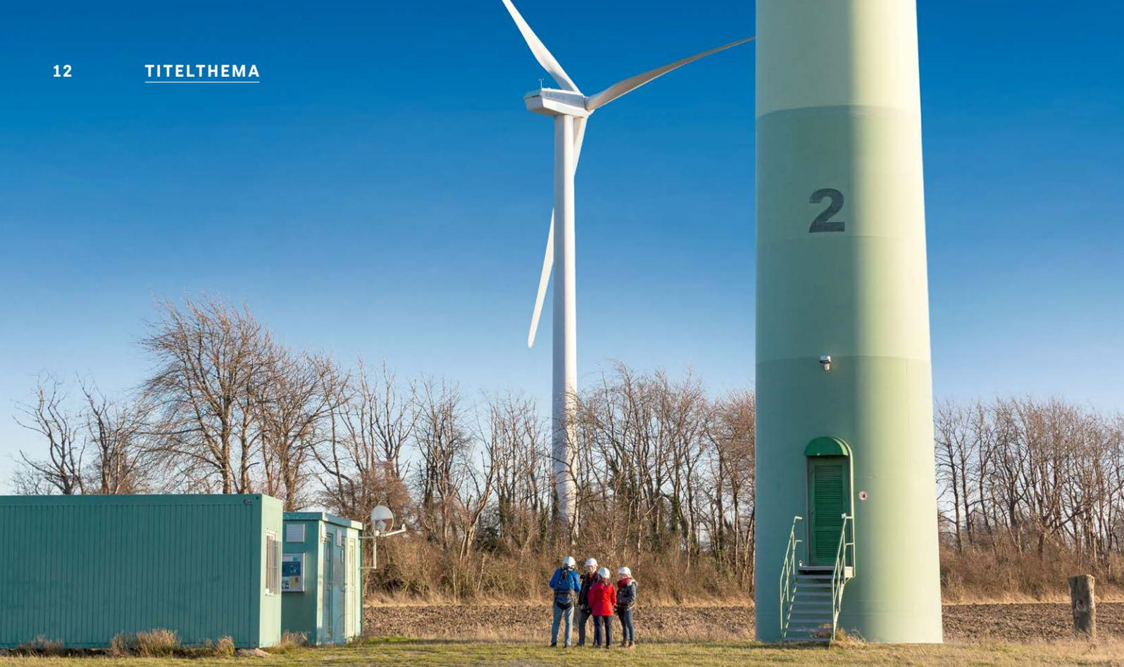
↑ Am Fuß der Windkraftanlage: Durch die grüne Tür geht es zu einer Wendeltreppe. Sie führt im Inneren des Turms über 300 Stufen zur Besucherplattform. Die benachbarten Windräder sind nur über eine Leiter im Turm zu erklimmen.
