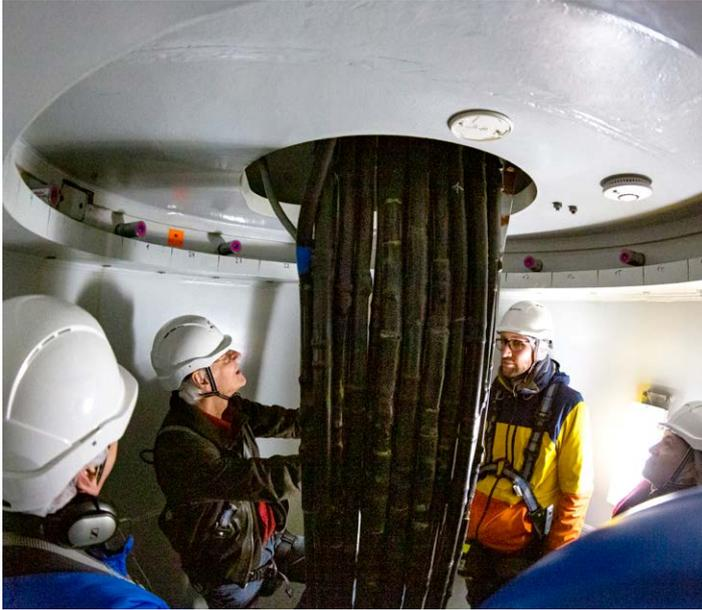
↑ Dicke Kabelstränge ziehen sich durch das Innere der Windkraftanlage. Durch sie fließen der erzeugte Strom und die Signale, um die Anlage zu steuern. Erst oberhalb der Besucherplattform sind sie sichtbar. Im normalerweise zugänglichen Bereich umhüllt sie ein Stahlmantel.
