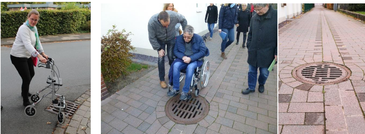
Abbildung 3: Gully in Querung, Beckum; Gullydeckel in Gehgasse, Rahden
