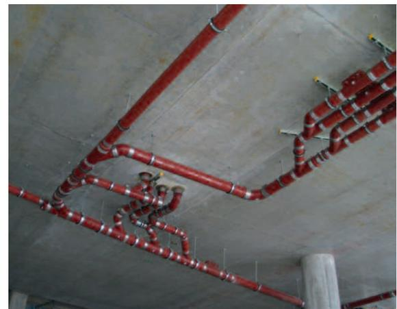
Foto „Nichtbrennbares gusseisernes Abflussrohrsystem PAM-Global S“ (SAINT-GOBAIN HES)
