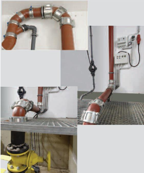
Fotos: Ausführungsbeispiele von Druckleitungen aus gusseisernen Abflussrohren
