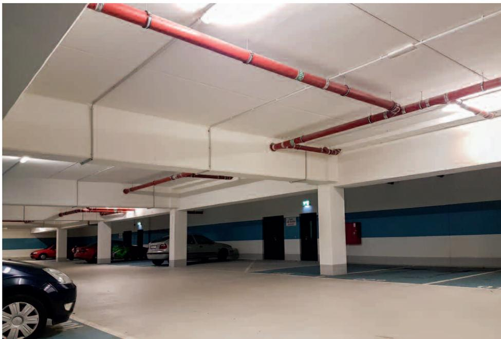
„Freiverlegte nichtbrennbare gusseiserne Entwässerungsleitungen innerhalb einer Tiefgarage“
