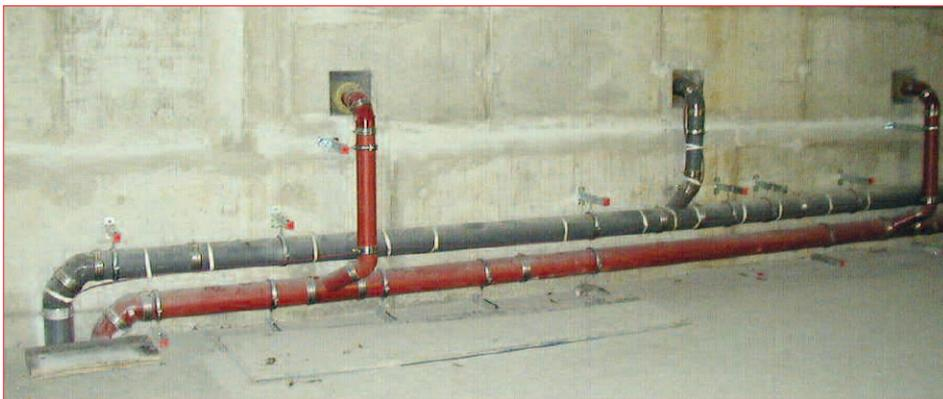
Gusseiserne Abflussrohrsysteme im Einsatz; oben: KML-Rohr für fetthaltige Abwässer; unten: SML-Rohr für häusliche Abwässer (Bild SAINT-GOBAIN HES)
