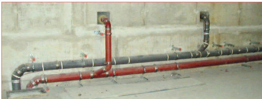
Gusseiserne Abflussrohrsysteme im Einsatz; oben: KML-Rohr für fettthaltige Abwässer; unten: PAM-GLOBAL® S (SML)-Rohr für häusliche Abwässer (Bild SAINT-GOBAIN HES)
