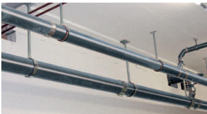
Foto „Nichtbrennbares gusseisernes Abflusssystem mit Sonderbeschichtung Typ MLK-protec“ (Düker)
