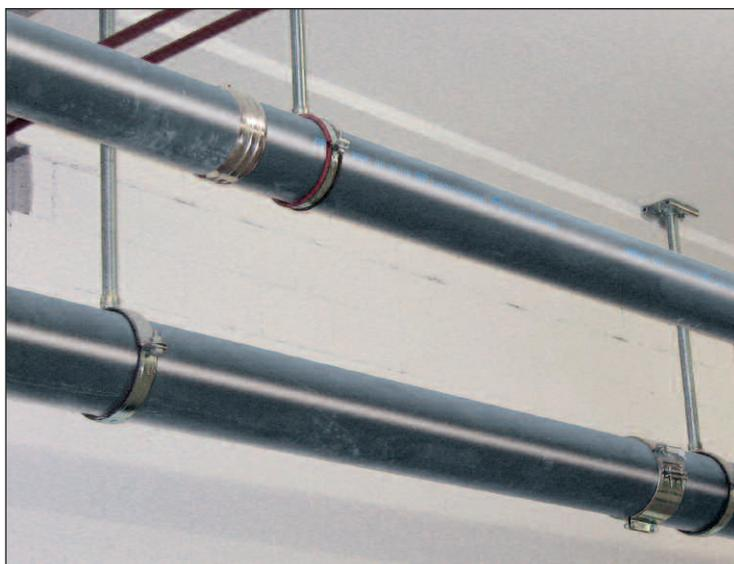
Foto „Nichtbrennbares gusseisernes Abflusssystem mit Sonderbeschichtung Typ MLK-protec“ (Düker)
