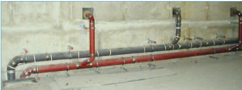
Gusseiserne Abflussrohre im Einsatz, oben: PAM-GLOBAL® Plus (KML)-Rohr für aggressive Abwässer unten: PAM-GLOBAL® S (SML)-Rohr für häusliche Abwässer (Bild: SAINT-GOBAIN HES)
