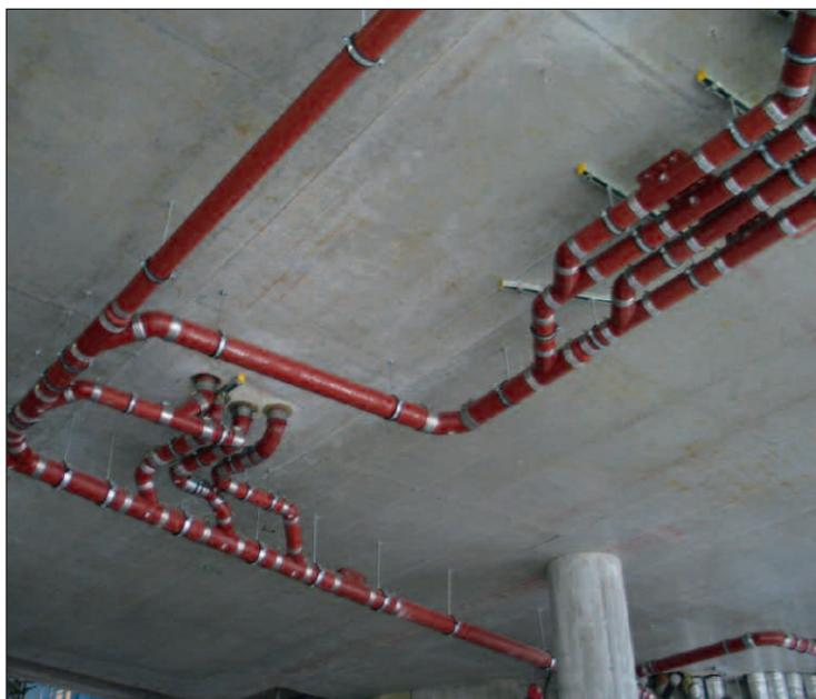
Foto „Nichtbrennbares gusseisernes Abflusssystem PAM-GLOBAL® S“ (SAINT-GOBAIN HES)
