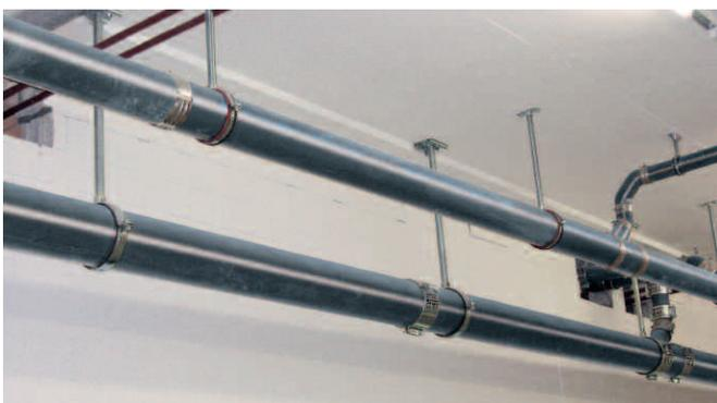
Foto „Nichtbrennbares gusseisernes Abflusssystem mit Sonderbeschichtung Typ MLK-protect“ (Düker)
