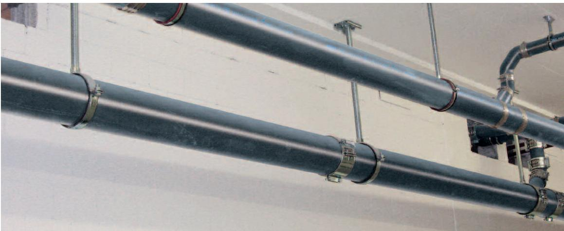
Gusseiserne Abflussrohrsysteme im Einsatz; MLK-protec Rohr für aggressive Abwässer; (Bild Düker)
