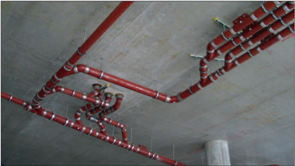
Foto „Nichtbrennbares gusseisernes Abflussrohrsystem PAM-Global S“ (SAINT-GOBAIN HES)
