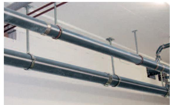
Foto „Nichtbrennbares gusseisernes Abflussrohrsystem mit Sonderbeschichtung Typ MLK-protect“ (Düker)
