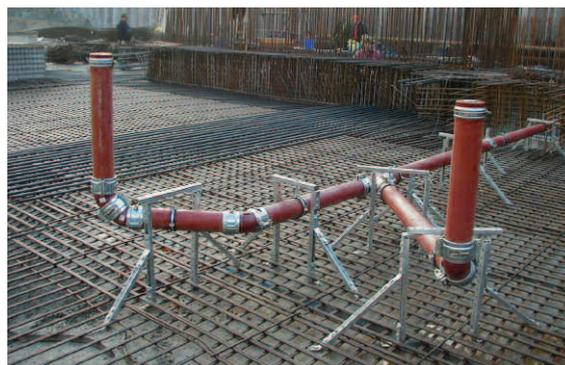
Foto Einbetonieren (SAINT-GOBAIN HES)
