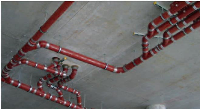
Foto „Nichtbrennbares gusseisernes Abflusssystem PAM-GLOBAL S“ (SAINT-GOBAIN HES)
