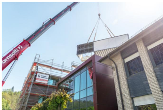
Das Foto zeigt, wie in Modulbauweise das neue Stockwerk mit den Büroräumen auf dem bestehenden Bürotrakt der Firma ALHO in Steeg aufgesetzt wurde. Foto: ALHO Holding GmbH
