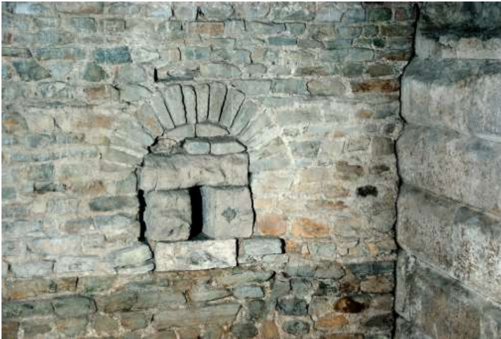
Kanaldurchlass durch die römische Stadtmauer neben dem Quaderbau des „Ubirmonuments“ (rechts)
