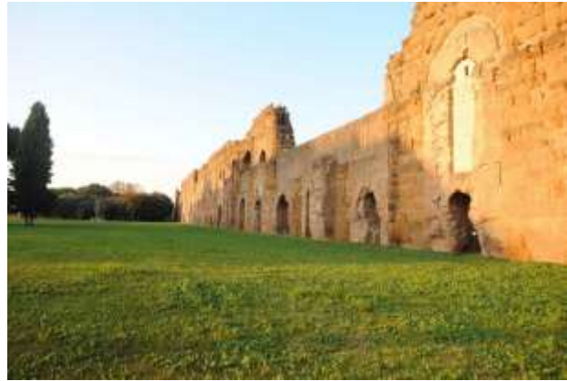
Abb. 4: Rom, Centro dello Sport der Banca d'Italia. Abschnitt der Aqua Marcia und der Aqua Claudia sowie der frühneuzeitlichen Acqua Felice
