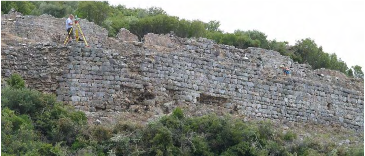
Abb. 7: Mauerwerk des Unterbaues des hadrianischen Aquäduktes im hohen Mauerstück von Abschnitt XVI, darüber die antoninische Leitung (Foto Verf.)
