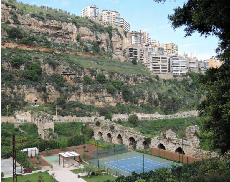
Abb. 1: Zubaida Brücke des römischen Aquäduktes nach Berytos : An der gegenüberliegenden Felswand ist direkt über dem „M“ der großen Schrift (Hazmieh - siehe Pfeil) der Kanalquerschnitt, darüber der Inspektionsgang zu sehen. Noch höher liegen rechts davon mindestens zwei Bögen der Einstiege in die Schächte. Links ist ein Bogen des untersten Geschosses, ganz rechts zwei Pfeilerreste des dritten Geschosses erkennbar
