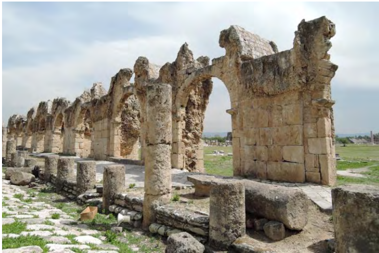
Abb. 2: Aquädukt von Tyros: Die Rückwand der Säulenhalle wurde als Auflager für den Kanal verwendet, sodass die erhaltenen Mauern zwischen den gewölbten Taberneneingängen wie die Pfeiler einer Aquäduktbrücke wirken. Dahinter liegen die teilweise wieder aufgebauten Ruinen des Hippodroms.
