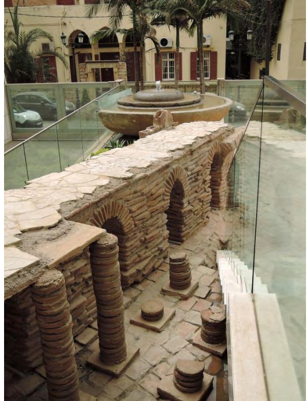
Abb. 8: Thermen im Saifi Crown Building: Die modern Treppe durchschneidet die Caldariumsecke, dahinter das reaktivierte römische Labrum.
