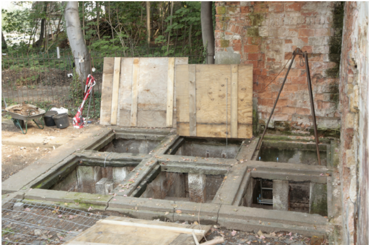
Ansicht der freigelegten Sieb- und Ablaufschächte des Hochplauenschen Wasserhauses
