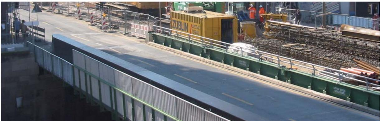
Während der Bauarbeiten für die Nord-Süd Stadtbahn fließt der Verkehr über eine Hilfsbrücke.
