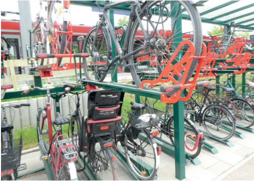
Kunstfehler: Das unten geparkte Rad mit Kindersitz blockiert das in der oberen Reihe abgestellte Rad.
