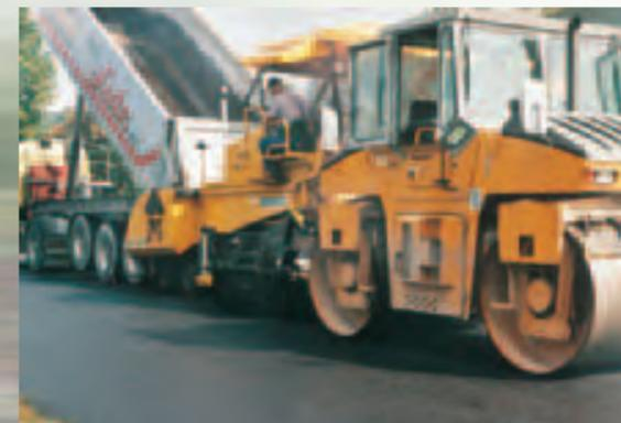
Die Asphaltdeckschicht mit Kalkstein wird aufgebaut
