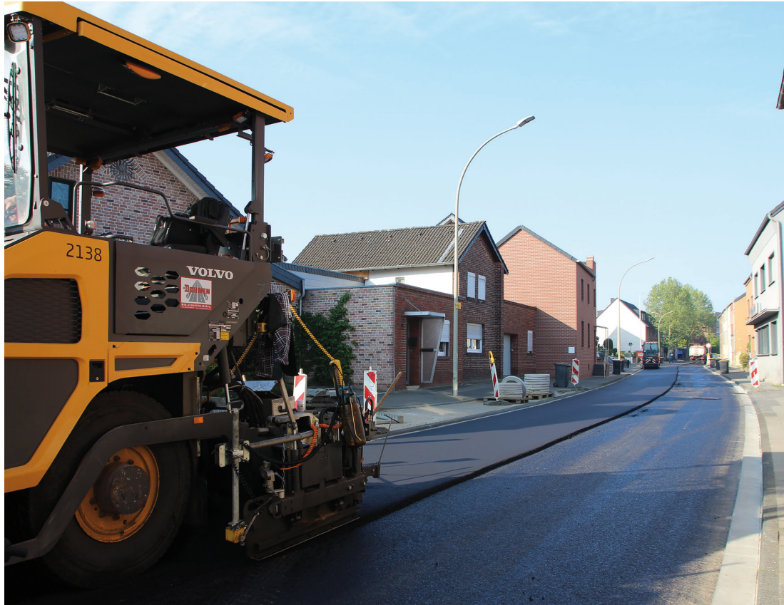
Abschlussarbeiten der Kanalsanierung in der Heerlener Straße
