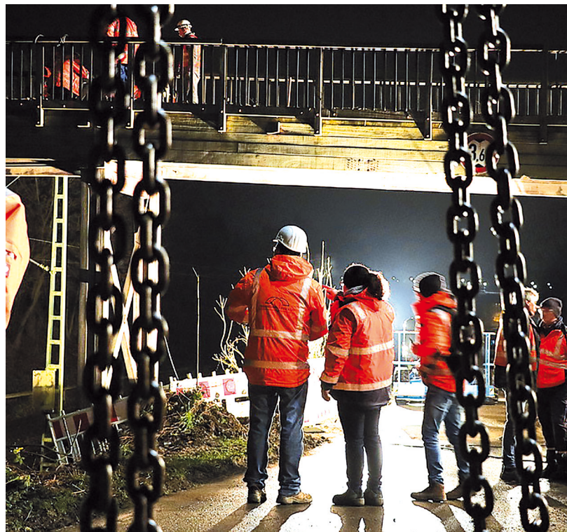
Bei den Abrissarbeiten der alten Brücke.
