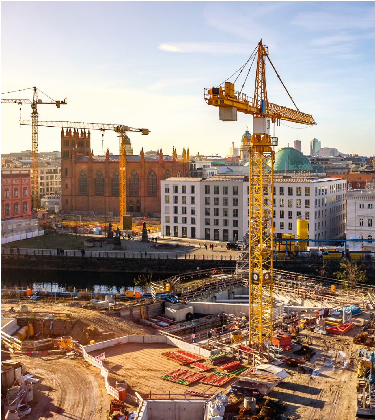
Großbaustelle in Berlin
