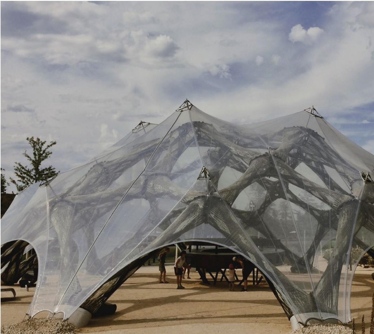
Vorbild Natur: Bionischer Faserpavillon aus Glas- und Carbonfasergewebe auf der Bundesgartenschau Heilbronn (Prof. Menges / Knippers, Universität Stuttgart). Das Projekt wurde im Rahmen der Zukunft Bau Forschungsförderung unterstützt
