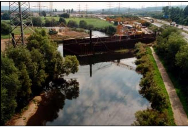
**Bild 9: Querung der Siegaue durch die ICE-Strecke Köln – Frankfurt: Bau des Siegauentunnels in offener Bauweise**
