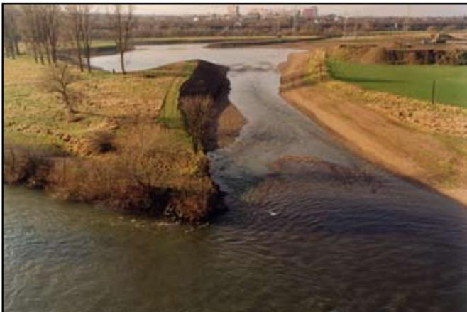
**Bild 99: Anlage einer Flutmulde bei Siegburg als Kompensation für die Querung der Siegaue durch die ICE-Strecke Köln – Frankfurt**
