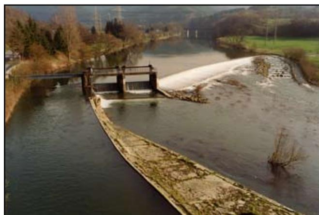
**Bild 78: Wehr Eitorf-Unkelmühle mit Triebwerksgraben, Absperrschütz und Fischaufstiegsrampe: Optimierungsbedarf für die Abwanderung von Jungfischen**
