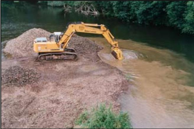
**Bild 100: Auflockerung und Waschen von Sohls substrat mit dem Roto-Cleaner bei Eitorf-Merten zur Verbesserung von Laichplätzen für Großsalmoniden**
