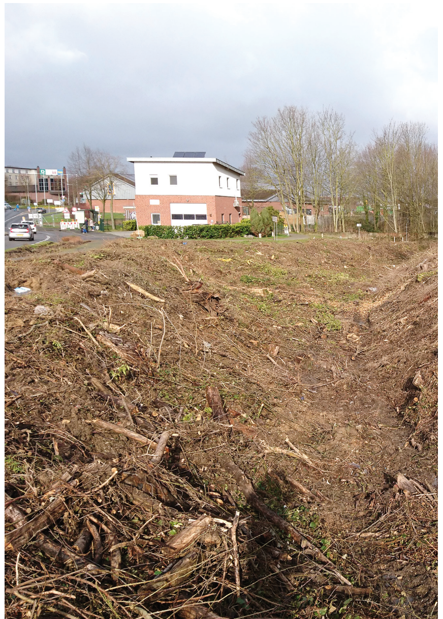
Erste Maßnahmen zur Errichtung der ca. 40 neuen Parkplätze an der Friedrich-Ebert-Straße.
