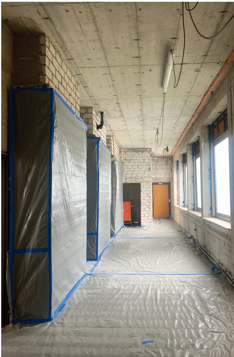
Die ersten Bauarbeiten im Gebäude des Carolus-Magnus-Gymnasiums im Zuge der Sanierung.
