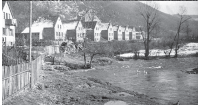
Die erste neue Siedlung, die in der Nachkriegszeit in Gemünd entstand, wurde in der neu angelegten Straße „Im Wingertchen“ gebaut. Das Foto zeigt die Rohbauten im Jahre 1949/50. Das Foto unten zeigt die bezugsfertigen Häuser 1950/51; und auch hier völlig identische Häuser (Quelle: Sammlung H. Wollgarten, Morsbach aus Nachlass W. Kruff, Malsbenden)
