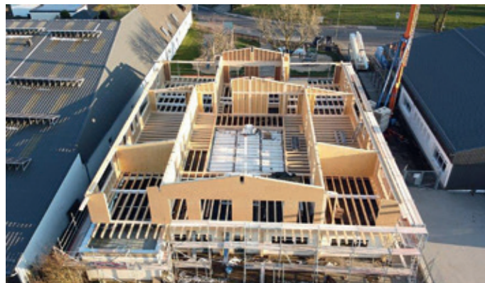
Luftaufnahme der Baumaßnahme. (© Firma Holzbau Engel)
