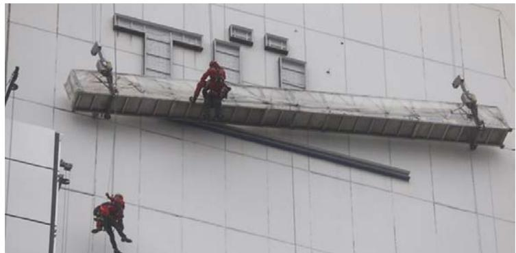
Durch die Mitarbeiter wurde beim ersten einseitigen Absacken der Gondel der Not-Aus-Schalter betätigt, so dass die Gondel sicher festgesetzt war. Durch die Firma wurden zuerst eigene Spezialkräfte beauftragt, die Störung der Gondel zu beheben. Durch den zeitlichen Verzug und eine lange Anfahrt dieser Kräfte wurde um ca. 8:50 die Feuerwehr Köln alarmiert.
