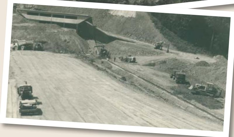
Innenkerndichtung und Steinschüttdamm im Bau, 1974/1975
