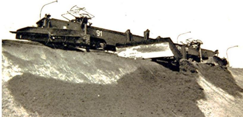
Bild 11: Pflugrücker bei Einsatz im Pflugkippenbetrieb<sup>24</sup>
