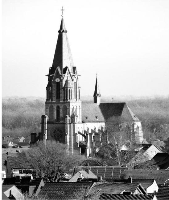
Bild 78: Die katholische Kirche in Gustorf. Nachdem sich Anfang der 50er Jahre Bauschäden zeigten, wurde der Turm wieder gerade gestellt und das Fundament des Bauwerks verstärkt.
