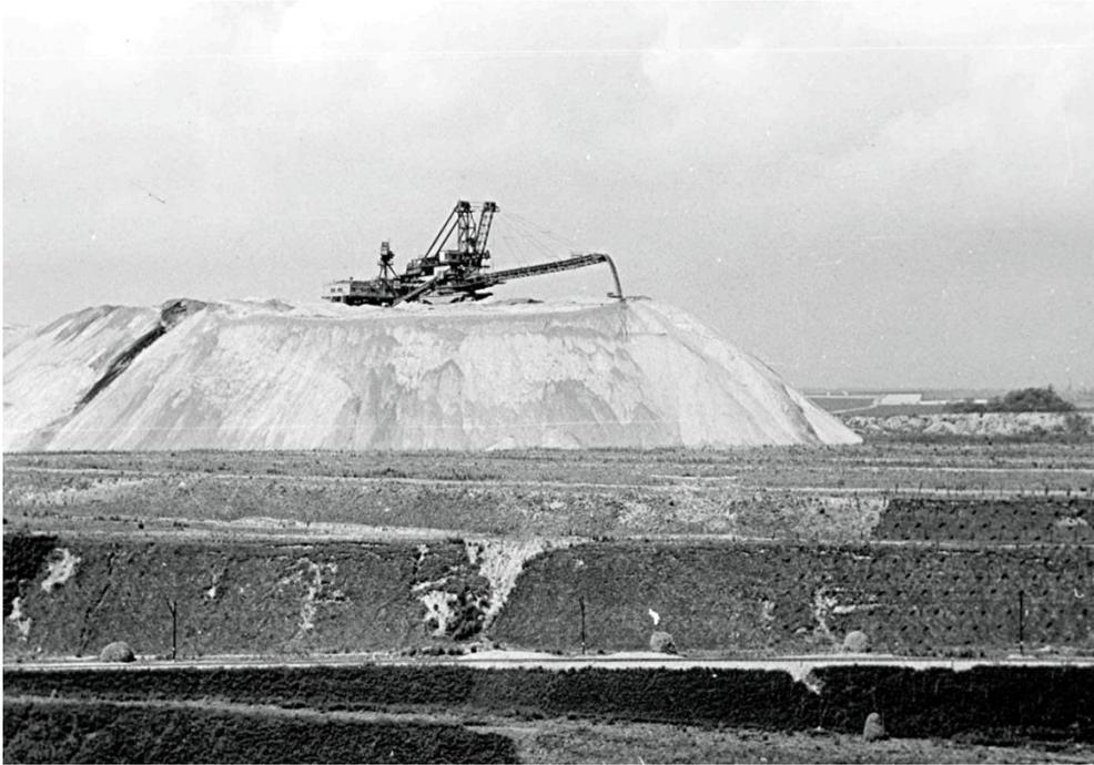
Bild 21: Abraumverkippung auf der Halde Vollrath mit dem Absetzer Nr.83 im Jahre 1967<sup>36</sup>
