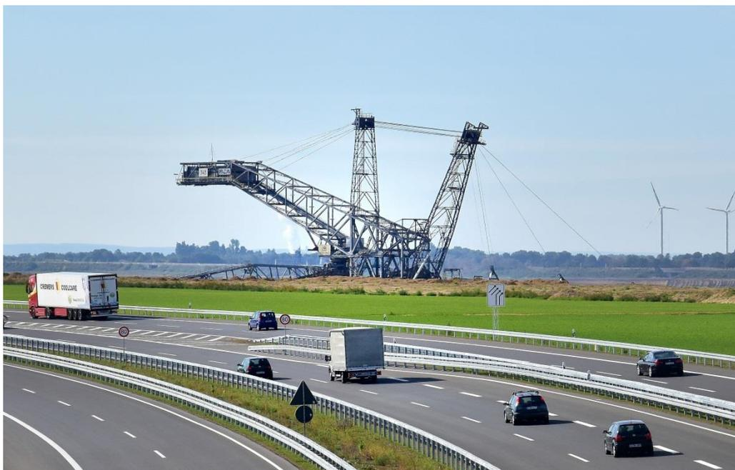
Bild 67: Die verlegte Autobahn A 44 auf einem aufgeschütteten Damm im Tagebau Garzweiler
