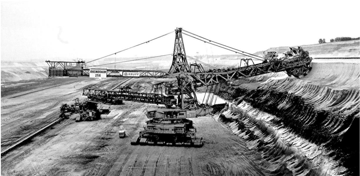
Bild 32: Schaufelradbagger 256, Garzweiler 1991 (© by Claudia Fährenkemper)
