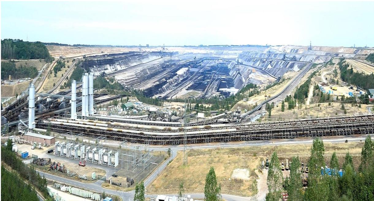
Bild 41: Tagebau Garzweiler II im Juli 2016. Links die Abbaufrente, rechts die Verkippungsseite, im Vordergrund die Bandanlagen für den Abraum- und den Kohletransport.
