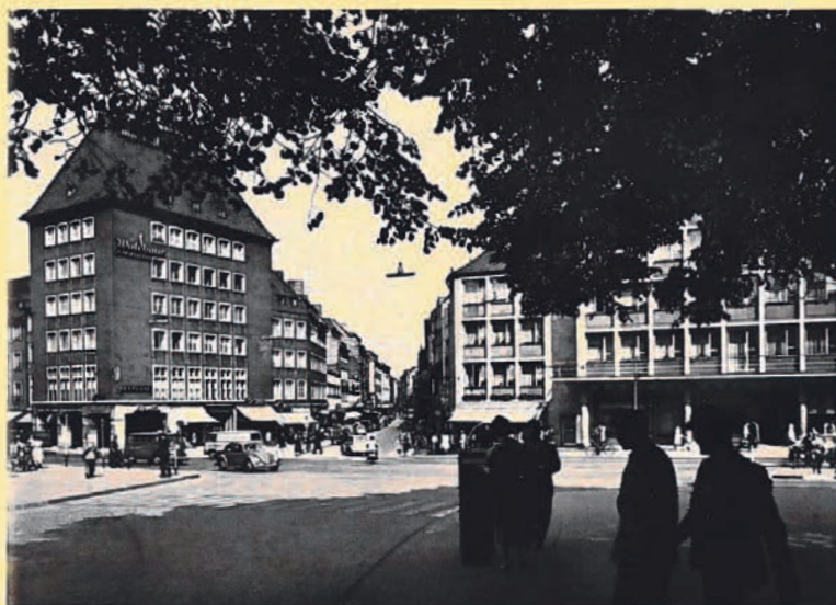
Aachen: Teil des wieder aufgebauten Geschäftsviertels (Adalbertstraße)
