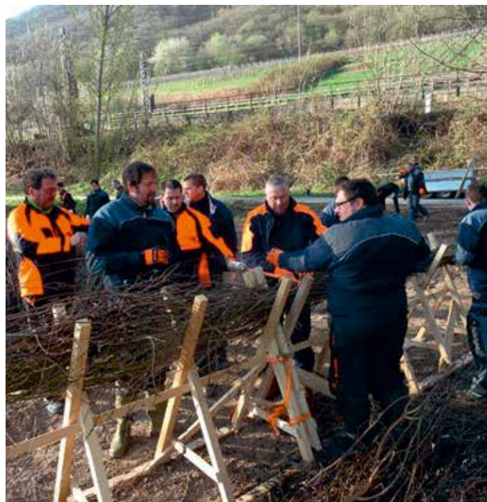
Mitarbeiter beim Bau einer sogenannten „Wippe“ zur Ufersicherung
