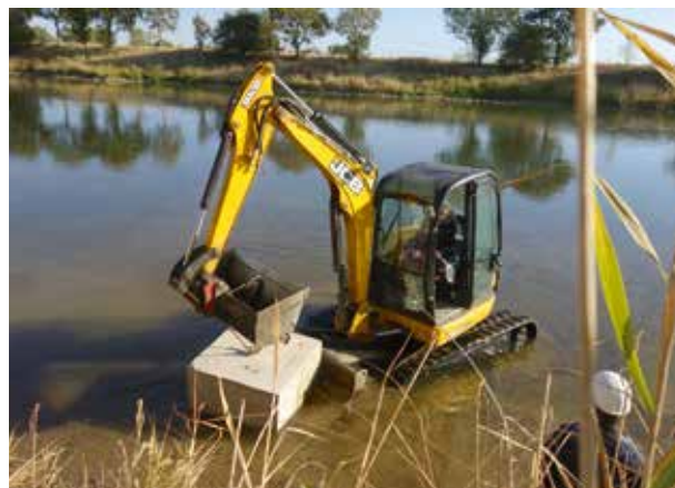
Einbringen des Schleppankers zur Fixierung der Totholzelemente
