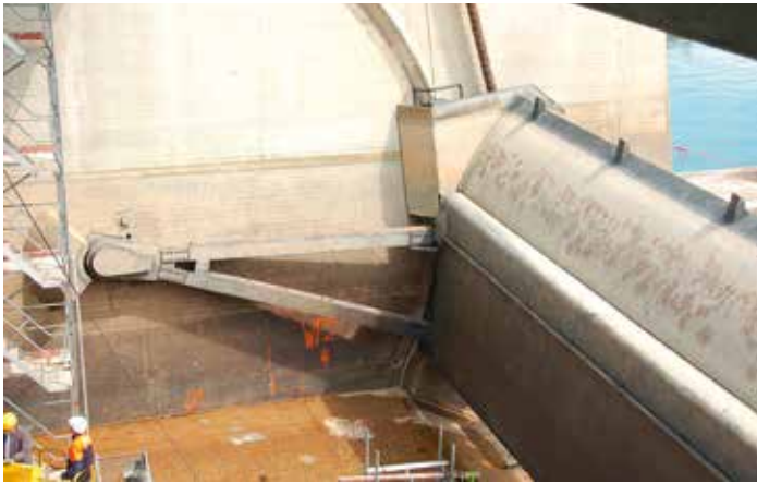
Zugsegmentverschluss Bad Abbach zur Trockenlegung
