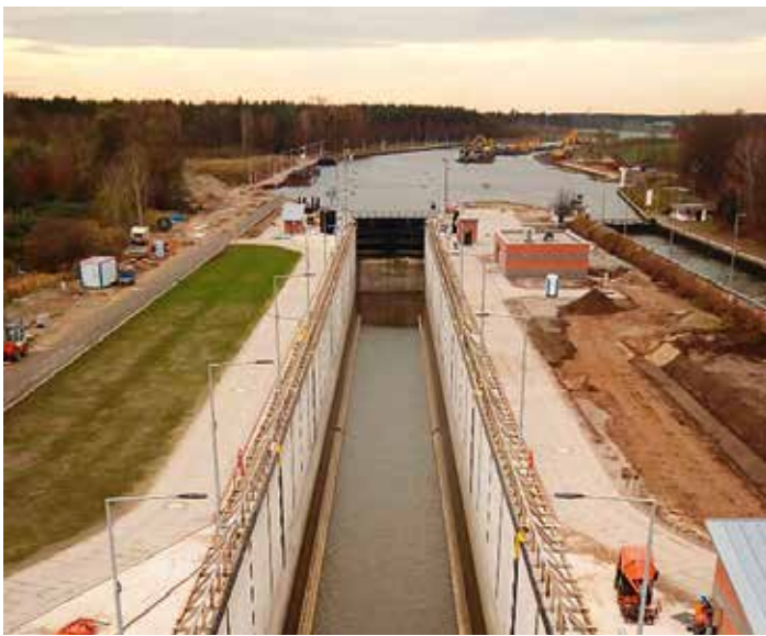
Neue Schleuse Zerben und oberer Vorhafen
