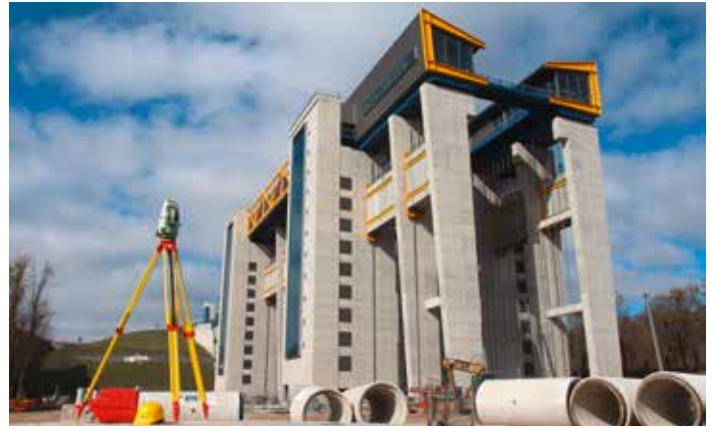
Neubau des neuen Schiffshebewerks Niederfinow
