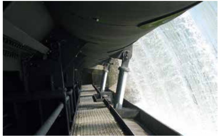
Hydraulikzylinder im Nassbereich
