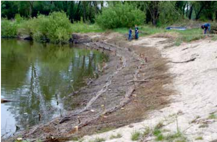
Technisch-biologische Ufersicherung mit Faschinen
