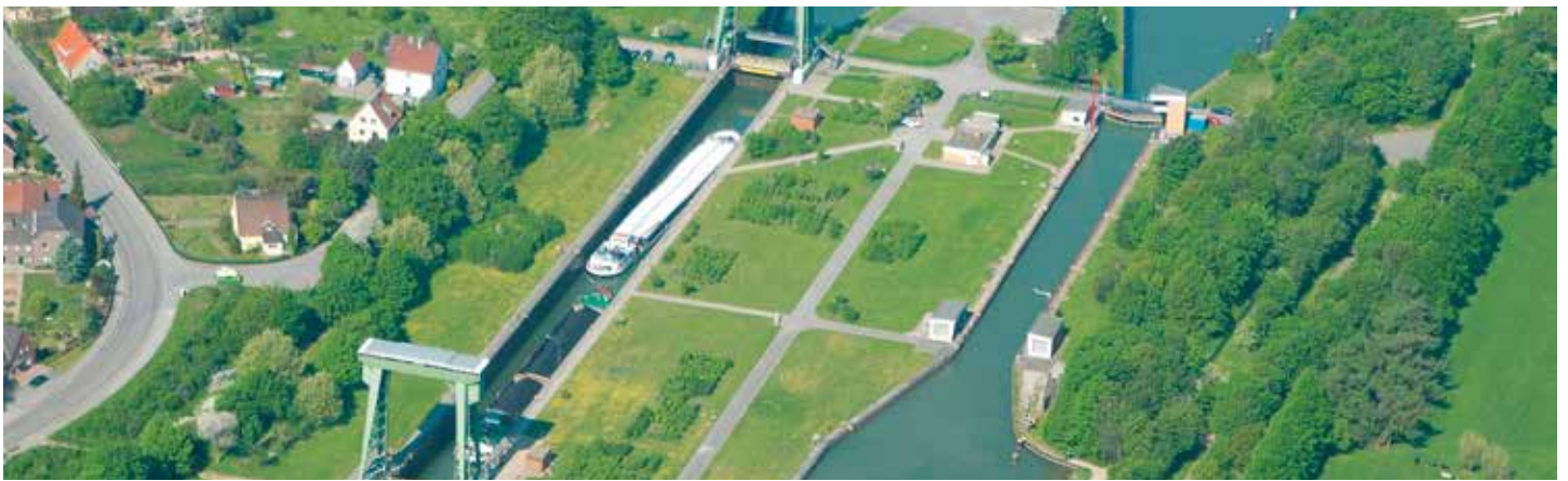
Schleuse Friedrichsfeld am Wesel-Datteln-Kanal
