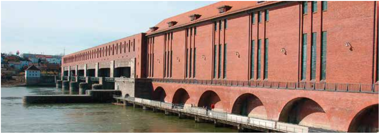
Wehranlage und Kraftwerk Kachlet (Passau)
