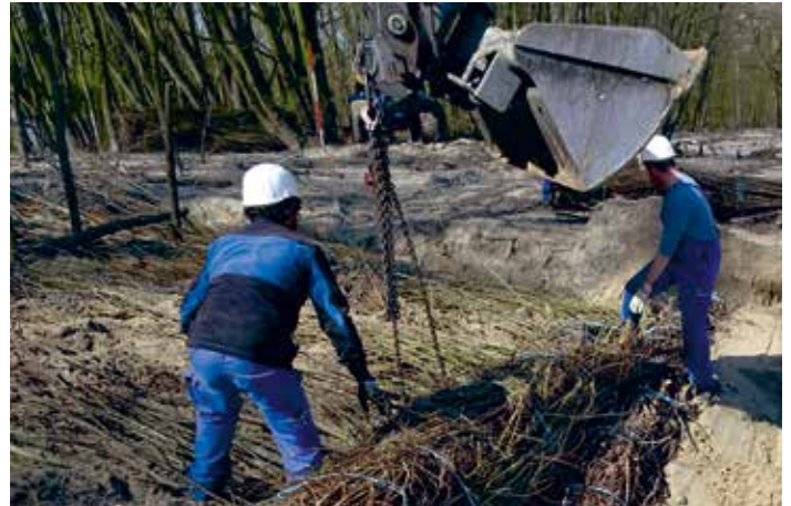
Verlegen der Fußsicherung
