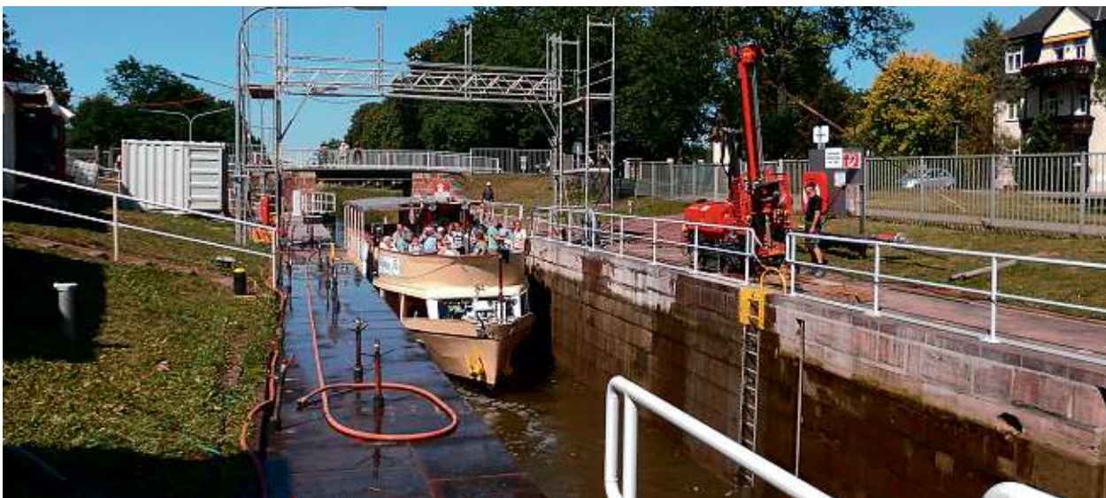
Instandsetzungsarbeiten der Schleuse Meuschau unter Betrieb
