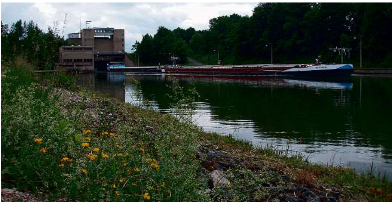
Die bestehende Schleuse Kriegenbrunn
