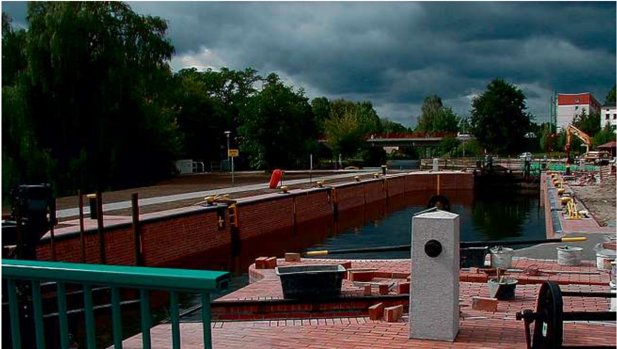
Unterhafen Schleuse Eberswalde
