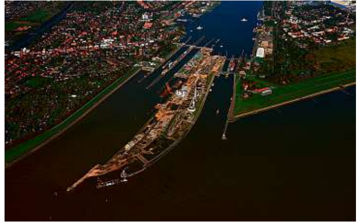
Neubau fünfte Kammer der Schleuse Brunsbüttel
