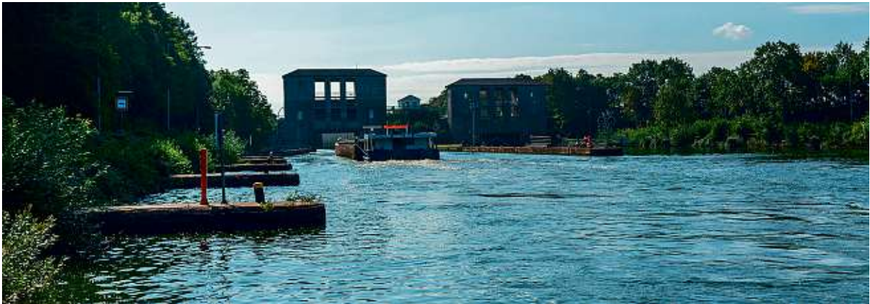
Unterer Vorhafen der Schleuse Üfingen
