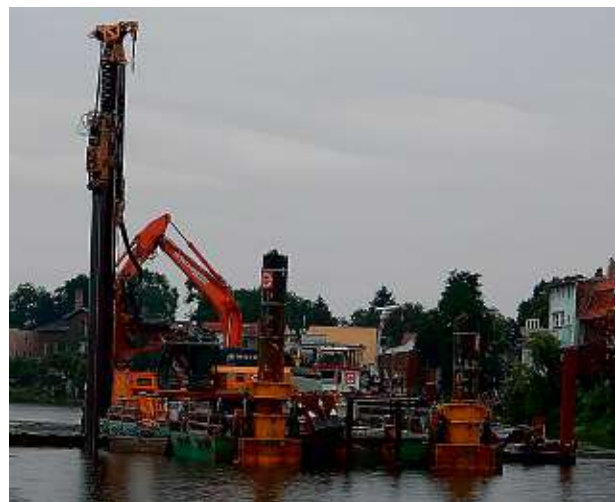
Spundwandarbeiten – Grundinstandsetzung Wehr Calbe
