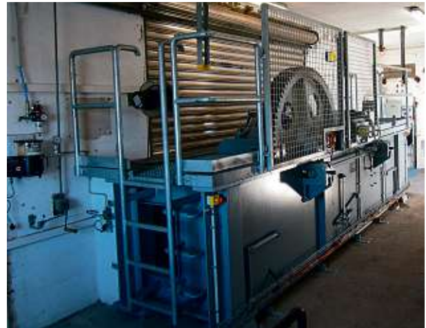
Windwerk nach Grundinstandsetzung
