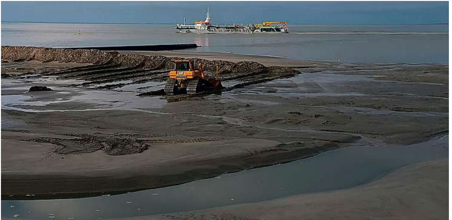
Verteilung des aufgespülten Sandes, im Hintergrund das Baggerschiff Charlock
