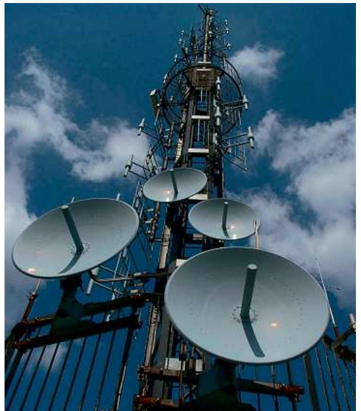
Antennenträger mit AIS-Antennen
