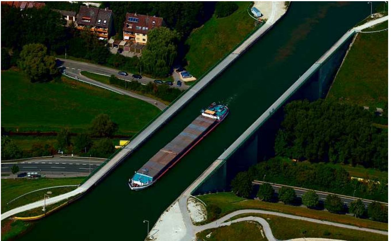
Kanalbrücke Zenn, Nürnberg, H. Dietz
