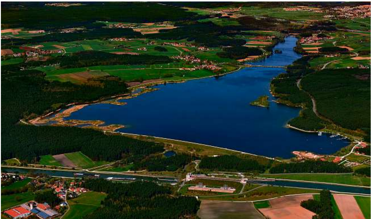
Schleuse Eckersmühlen und Rothsee, Nürnberg, H. Dietz
