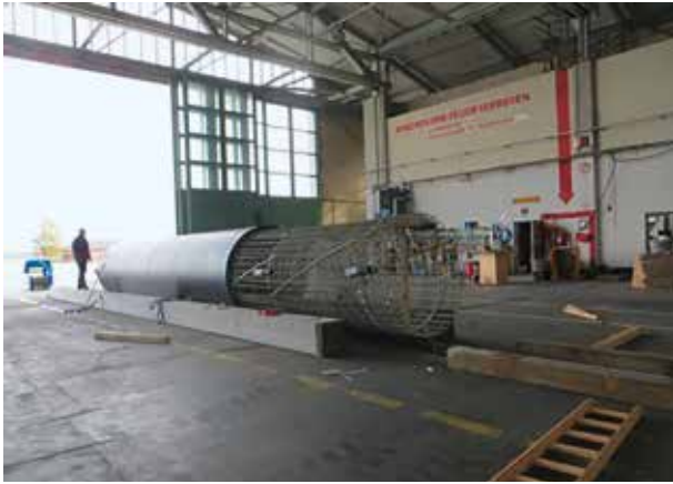
Herstellung von kunststoffbewehrten Fertigbetonpfählen
