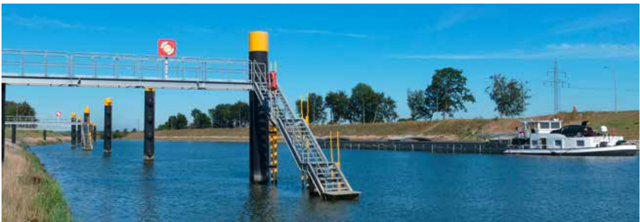
Unterer Vorhafen Warteplatz mit Landgangsteg und Treppe. Die Böschung ist bereits bewachsen.
