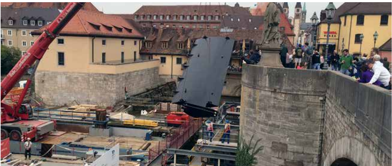
Einheben der neuen Fischbauchklappe
