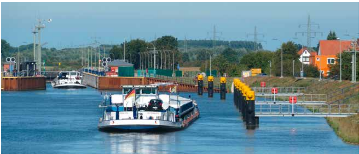
Oberer Vorhafen Dörverden mit Liegestelle und Landgangstegen, im Hintergrund ist die Schleuse zu sehen.
