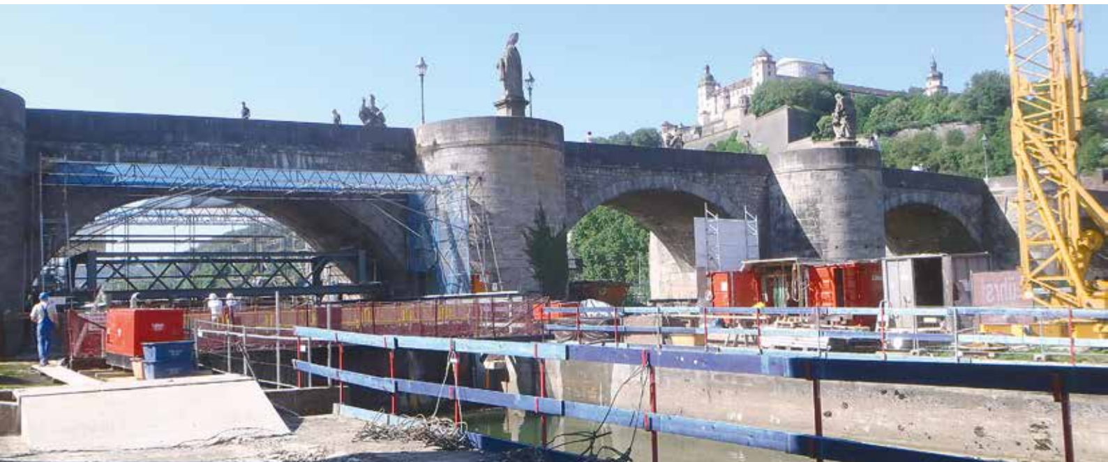
Blick vom Kraftwerk im Unterwasser auf die Baustelle, Alte Mainbrücke mit Passanten und im Hintergrund die Festung Würzburg
