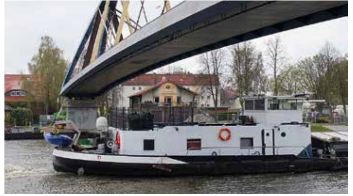
Schiffsverkehr unter der neuen Brücke – In Summe sind für die Brückenmaßnahme 2 Mio. € durch die WSV investiert worden.
