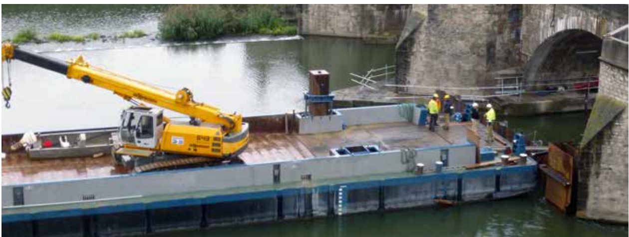
Baubeginn Frühjahr 2016 mit Wiedererrichtung der Baugrubenumschließung Oberwasser
