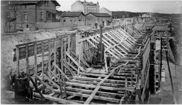
Bau der zweiten Schleuse Wernsdorf, 1903
