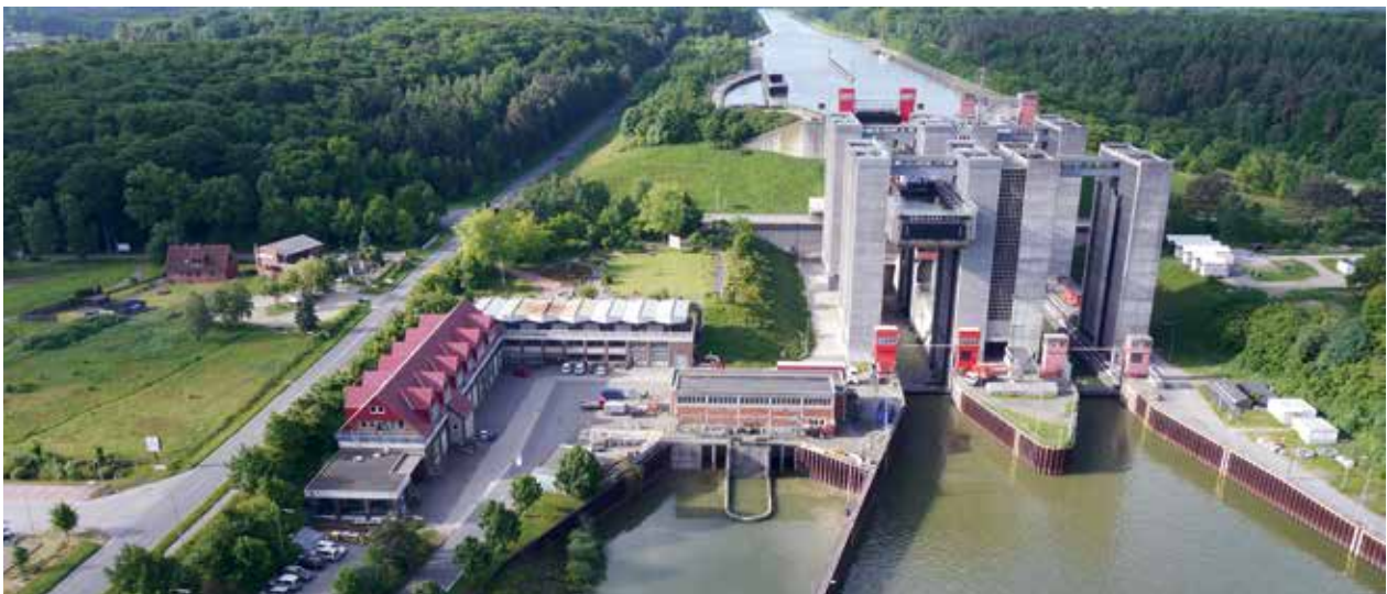
Schiffshebewerk Lüneburg und Bauhof WSA Uelzen
