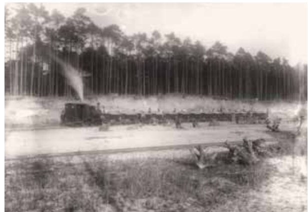
Kanalbauarbeiten im märkischen Sand, um 1888
