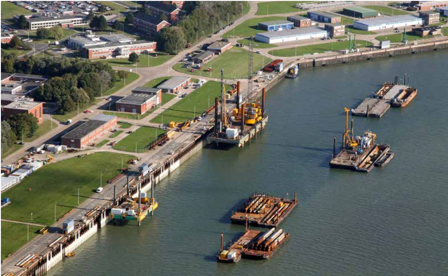
Westkaje Rammarbeiten Mai 2016
