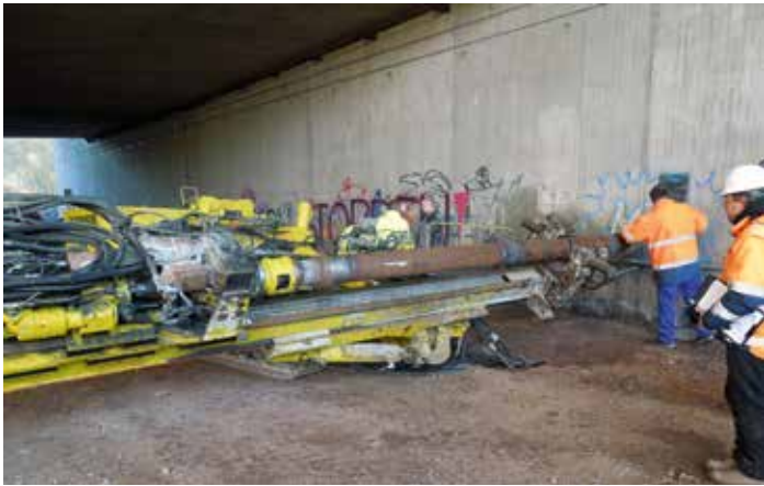
Bohrung für Horizontaldränagen an der Kanalbrücke Katzengraben, Main-Donau-Kanal
