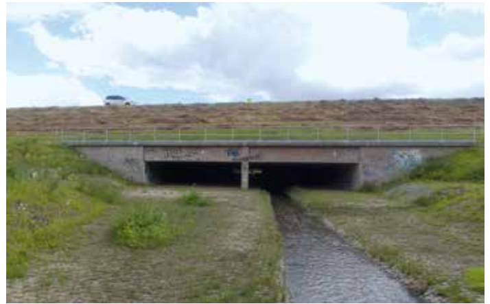
Durchlass Farrnbach, Main-Donau-Kanal
