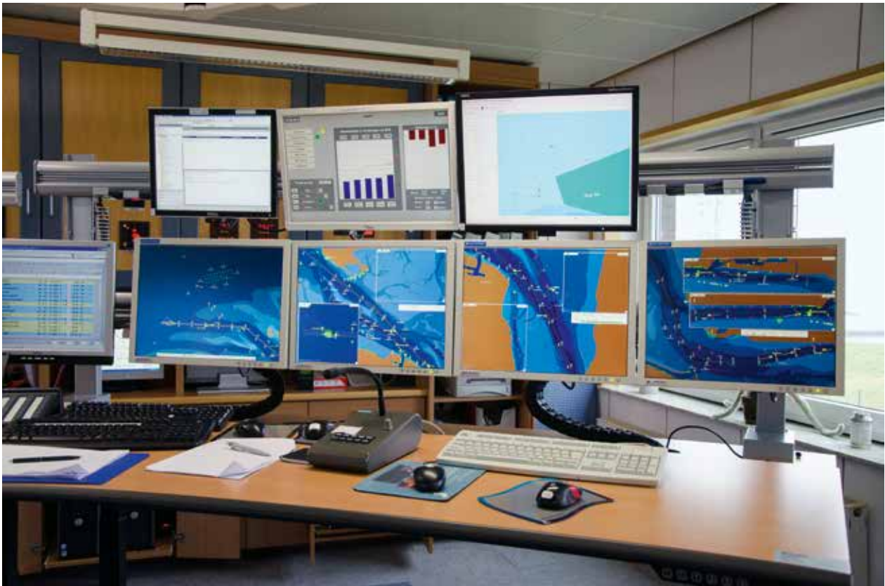
Blick in die Verkehrszentrale Ems
