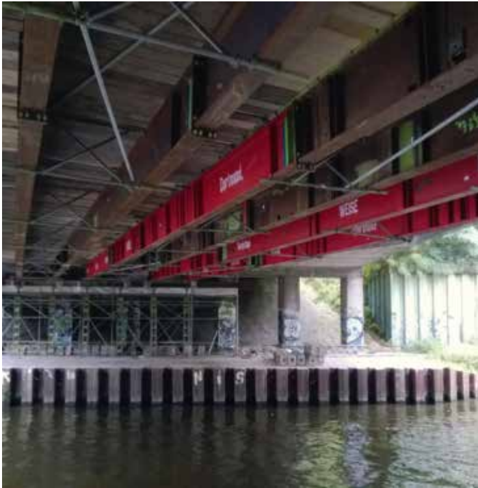
Aufwendige Rüstung unter der Sieversbrücke
