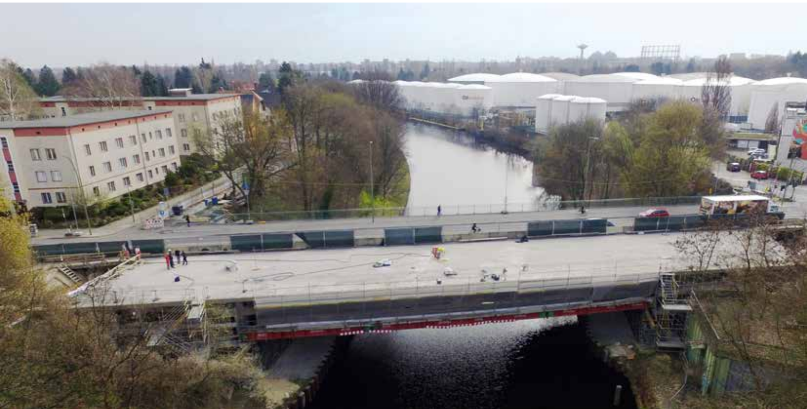
Luftbild Sieversbrücke Bauzustand
