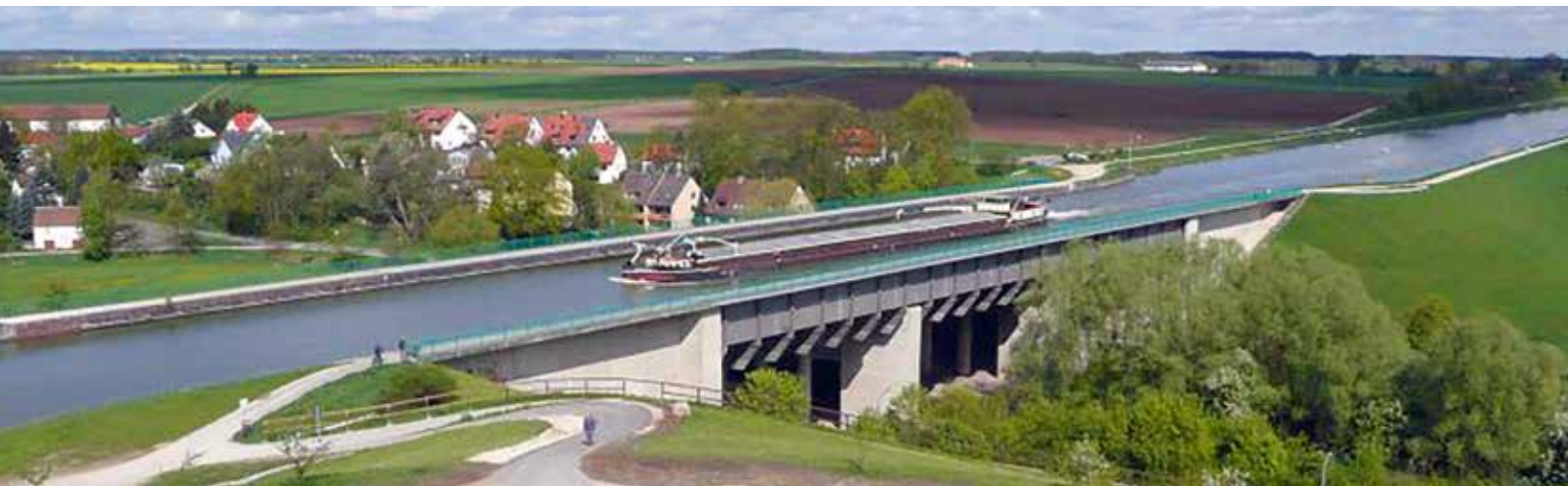
Kanalbrücke Zenn, Main-Donau-Kanal
