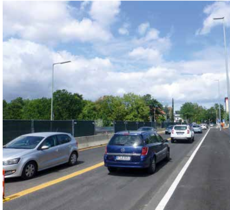
Verkehrsfreigabe für den 1. Bauabschnitt
