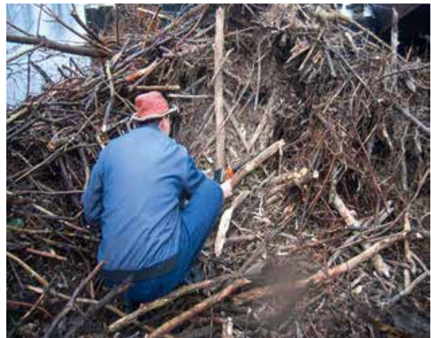
Nochmalige Kontrolle einer im Baufeld befindlichen Biberburg auf aktuelle Nutzung mittels Endoskopkamera während des Abtrags
