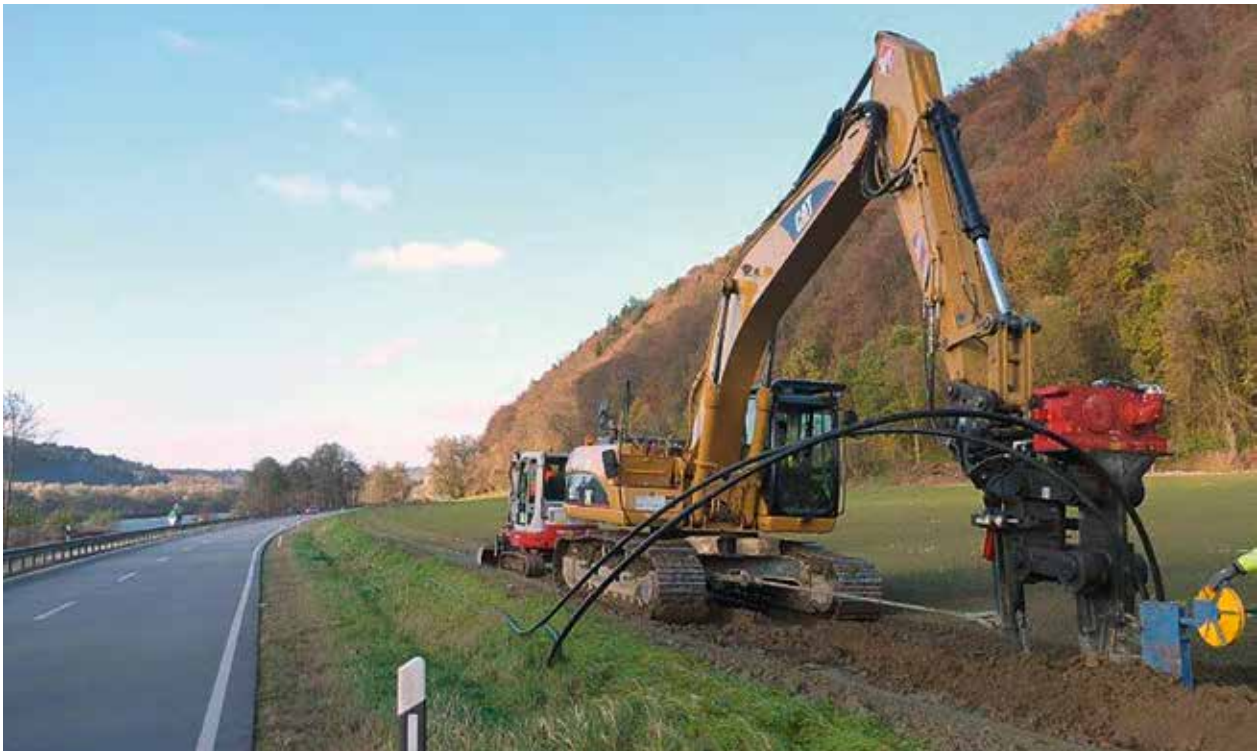
Einbau des Kabels mittels Pflugverfahren
