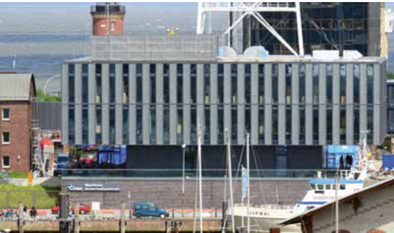
Der Neubau des maritimen Kompetenzzentrums MSZ
