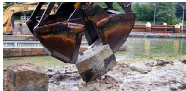
Bergung des Grundsteines beim Rückbau der Schleuse Große Tränke, 2004
