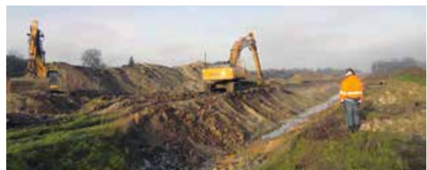
Herstellung des neuen Kanalseitengrabens im Winter 2013/2014
