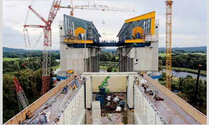
Neubau des neuen Schiffshebwerks Niederfinow
