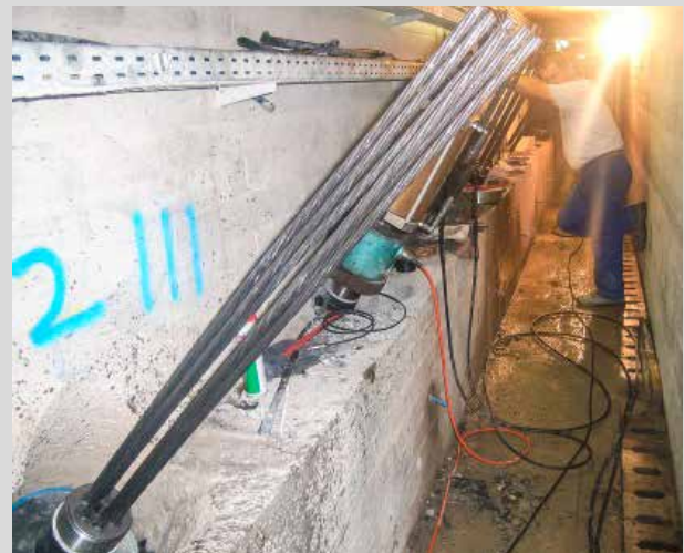
Einbau von Zugankern im oberen Wartungsgang
