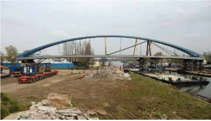
Einschub zweiter Stützponton
