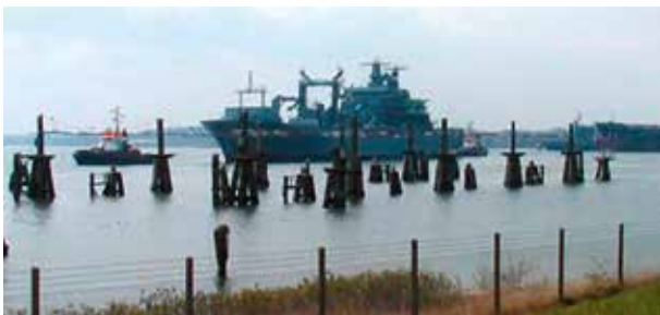
Alte Entmagnetisierungs-Behandlungsanlage in Kiel-Friedrichsort
