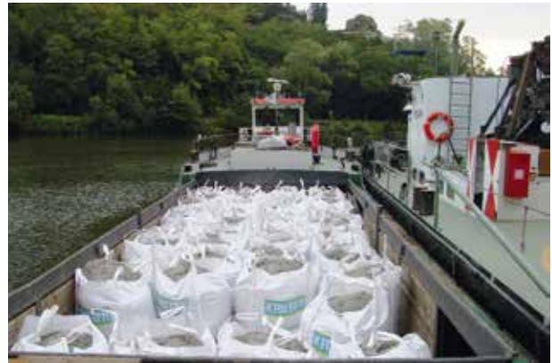
Bigpacks zum Verschließen des Nebengewässers
