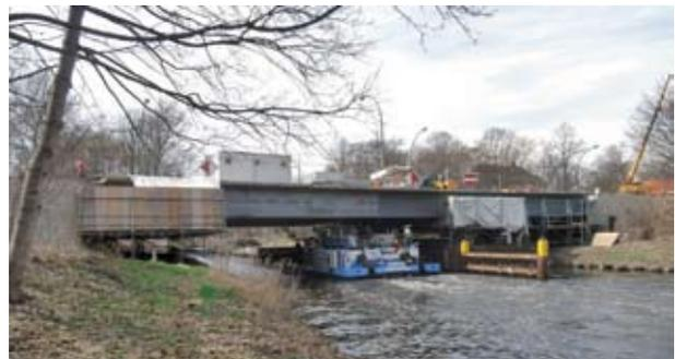
Korrosionsschutzarbeiten über Wasser
