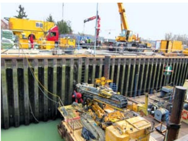
Ankerbohrungen in der Spundwand 2014
