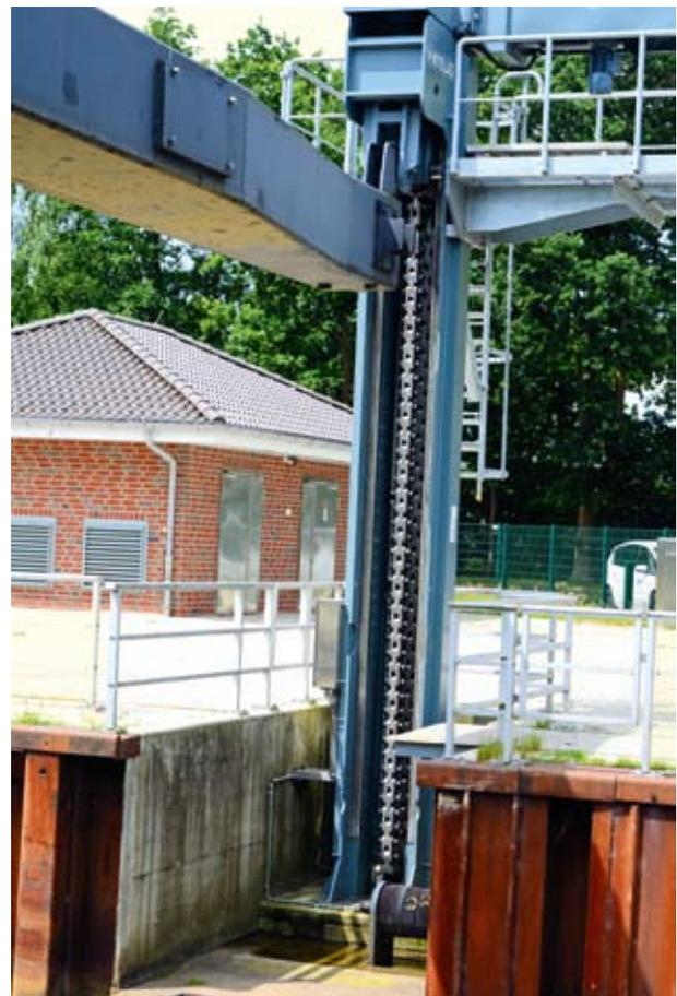
Hinter der Kammerwand: Stoßschutzsystem mit Elastomere – Fender
