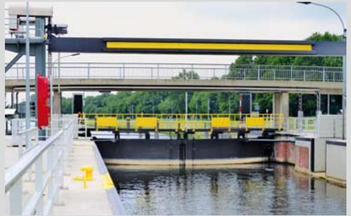
Stoßschutzanlage mit nach oben verfahrenen Balken
