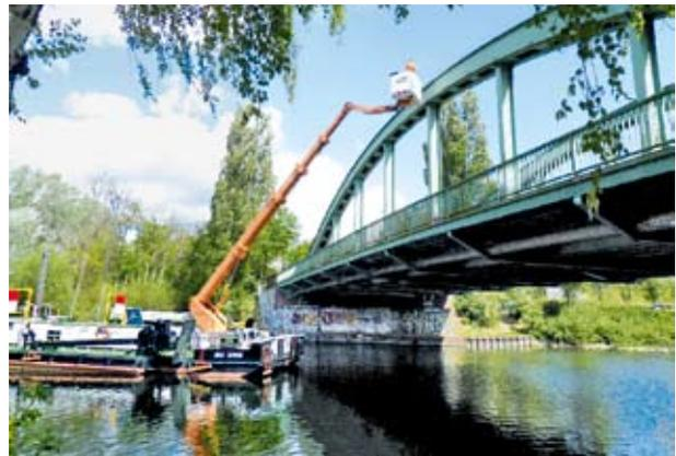
Brückenuntersuchungsschiff mit Hubarbeitsbühne
