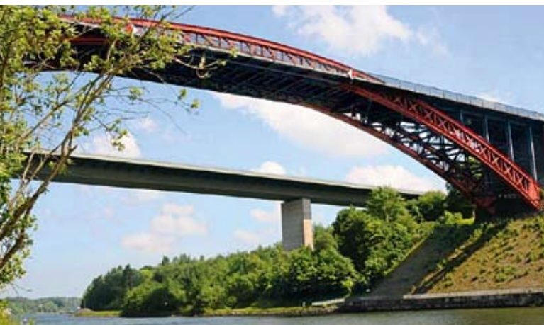
Levensauer Eisenbahn- und Straßenhochbrücke
