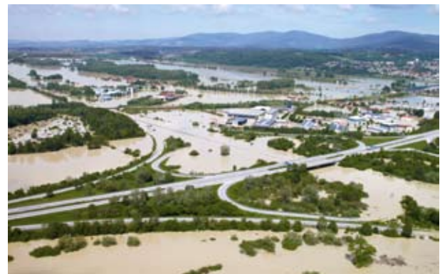
Hochwasser Bundesautobahn A3 bei Deggendorf im Juni 2013
