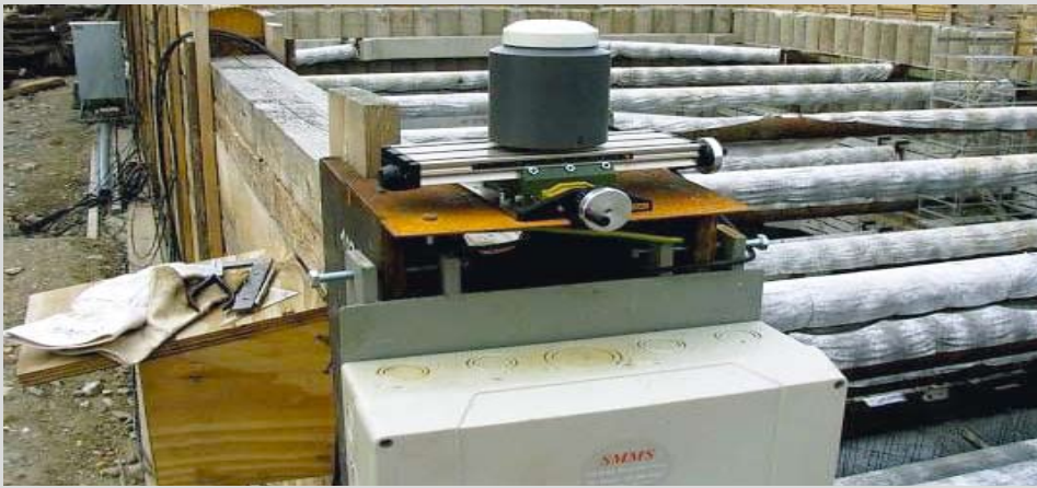
Satellitenantenne mit Spezialaufnahme zur Überwachung der Baugrubensicherung
