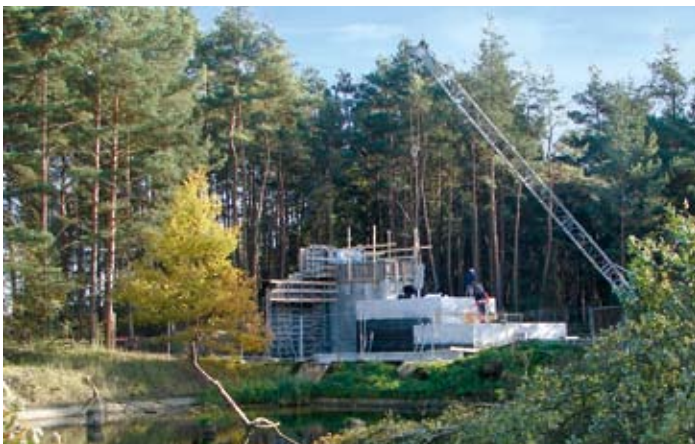
Blick auf die Baustelle
