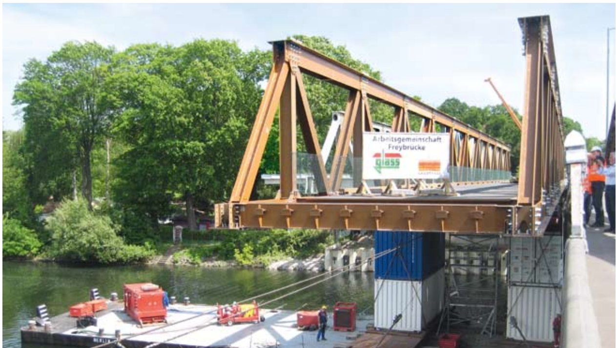
Einbau einer Behelfsbrücke an der Freybrücke
