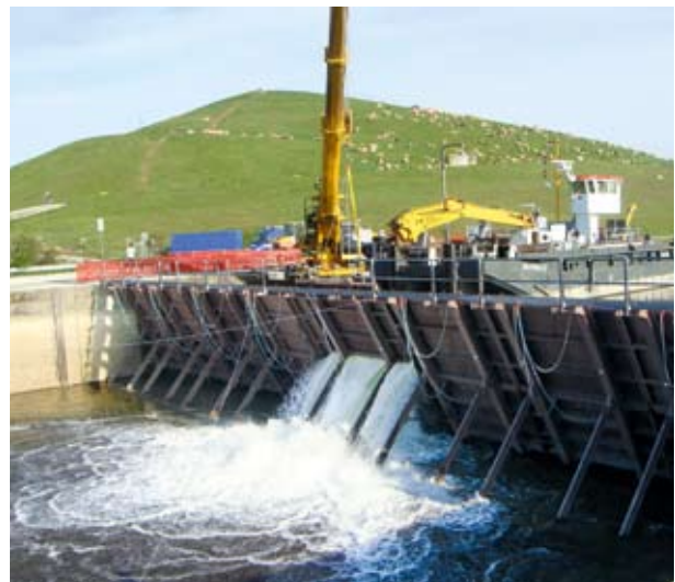
Flutung der Kanaltrogbrücke Zenn
