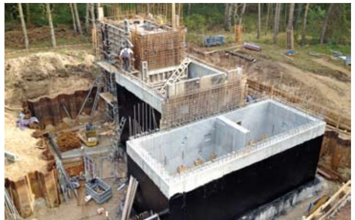
Kammern im Bau
