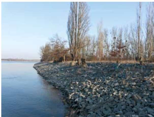
Mit Steinen gesichertes Ufer am Rhein
