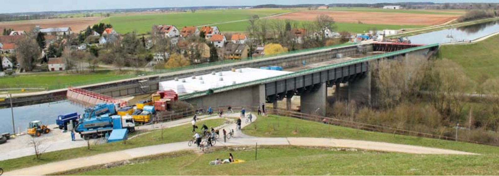
Korrosionsschutzarbeiten Einhausung Trogboden
