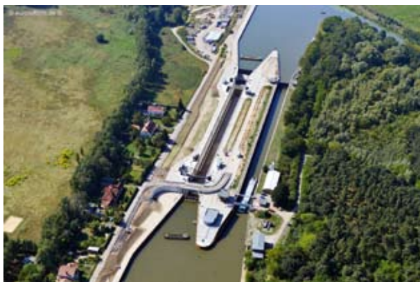
Neubau der 2. Schleuse Wusterwitz
