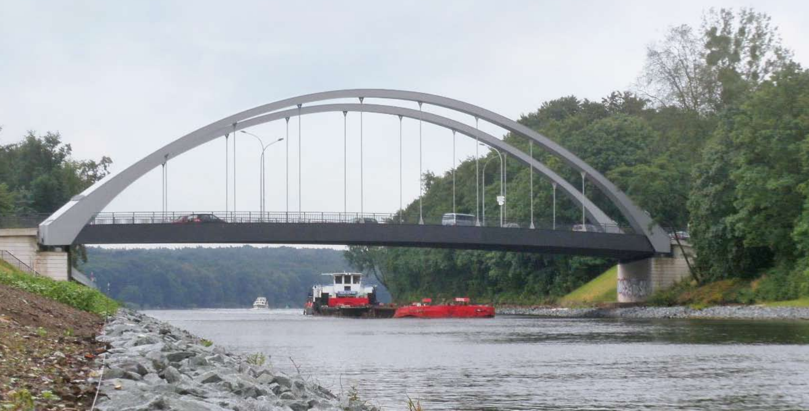
Ausgebauter Nedlitzer Durchstich im Sacrow-Paretzer Kanal
