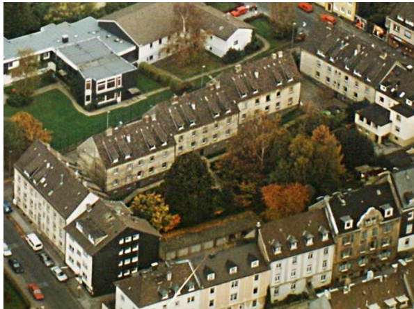
Foto: Luftbild GEWAG-Gebäude (Quelle: Stadt Remscheid)
