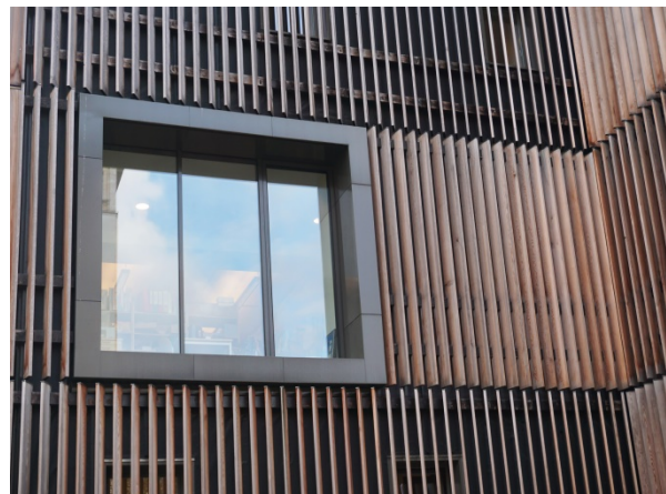
Foto: Fassade der Bezirkszentralbibliothek (Quelle: steg NRW)
