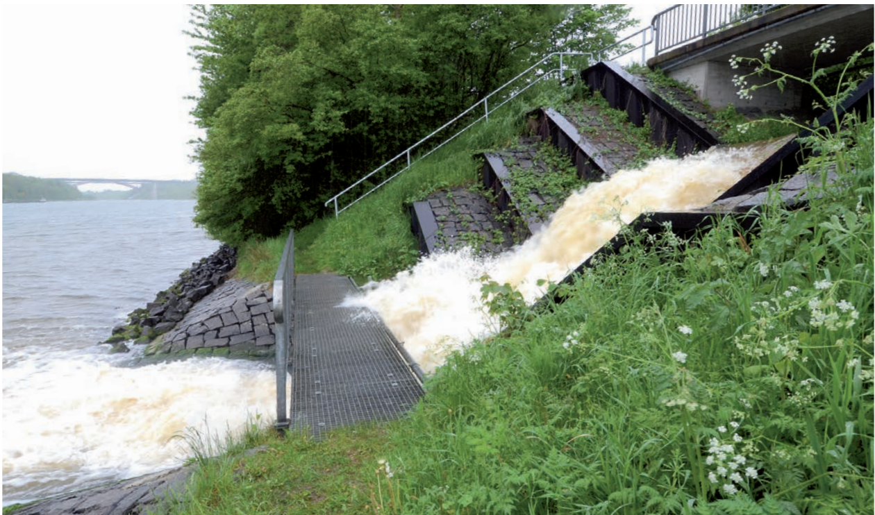
Einlaufbauwerk bei Projensdorf
