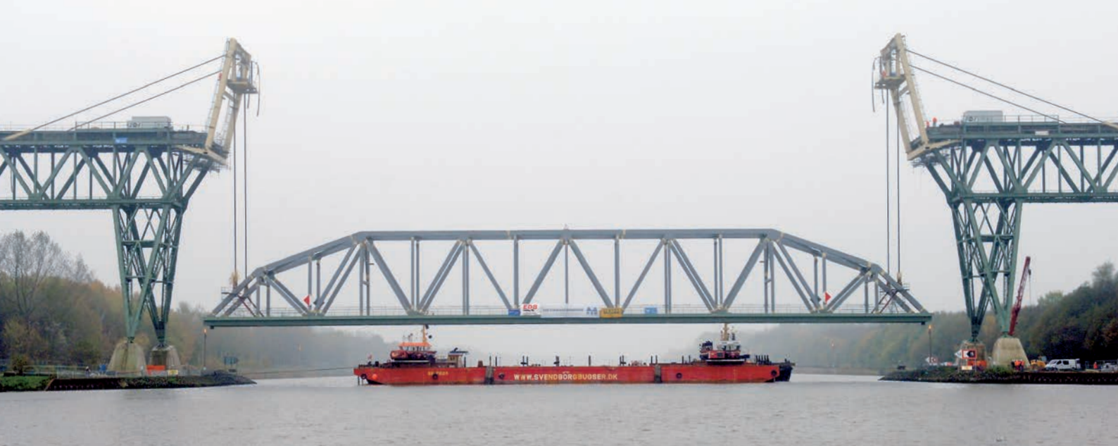
Einsatz des Mittelteils der Eisenbahnhochbrücke, Hochdonn
