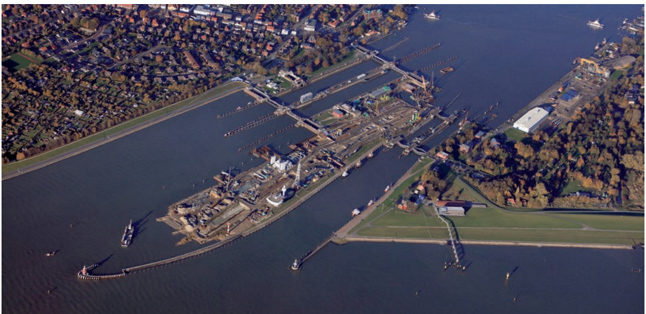
Schleusenanlage Brunsbüttel im November 2018
