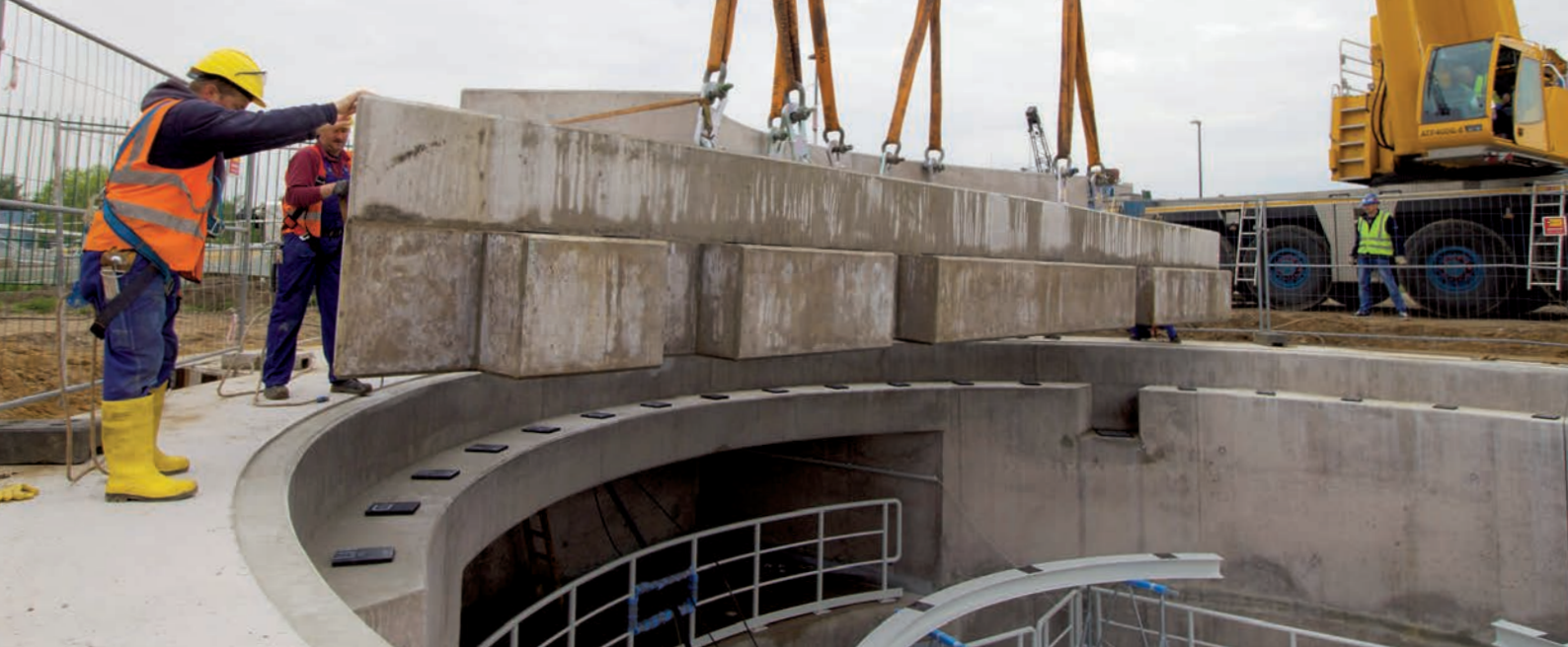
Düker in Kiel-Holtenau, das Einheben des dreiteiligen, 175 Tonnen schweren Schachtdeckels am Startschacht
