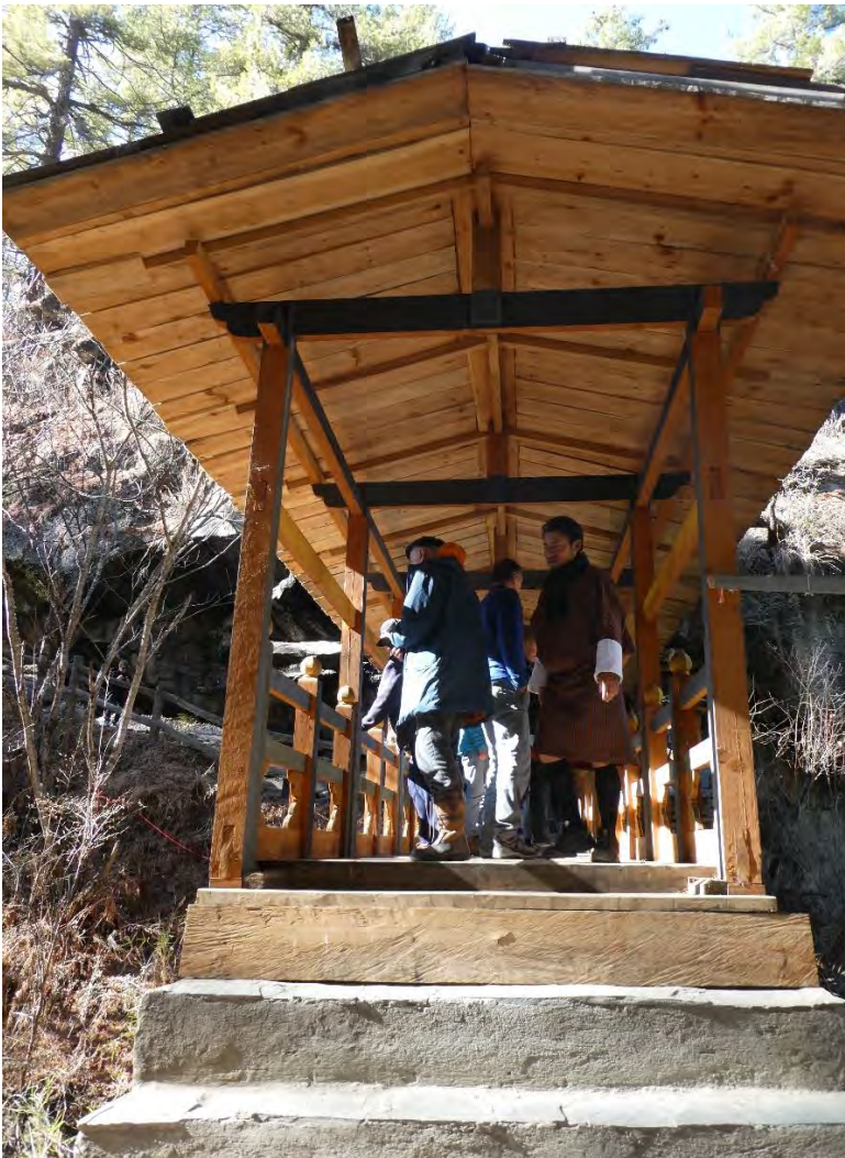
Das Brückendach vor dem Altarschrein wurde – statt des vorher sichtbaren Wellblechs – auch auf der Unterseite mit Kiefernholz verkleidet
