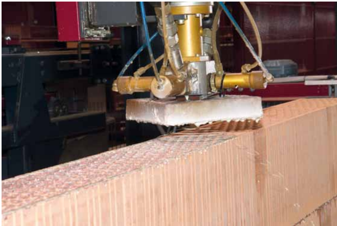
Bild 2: Auftrag des 2K-Polyurethan-Klebstoffs auf eine Mauersteinlage. Foto: Redbloc Elemente GmbH
