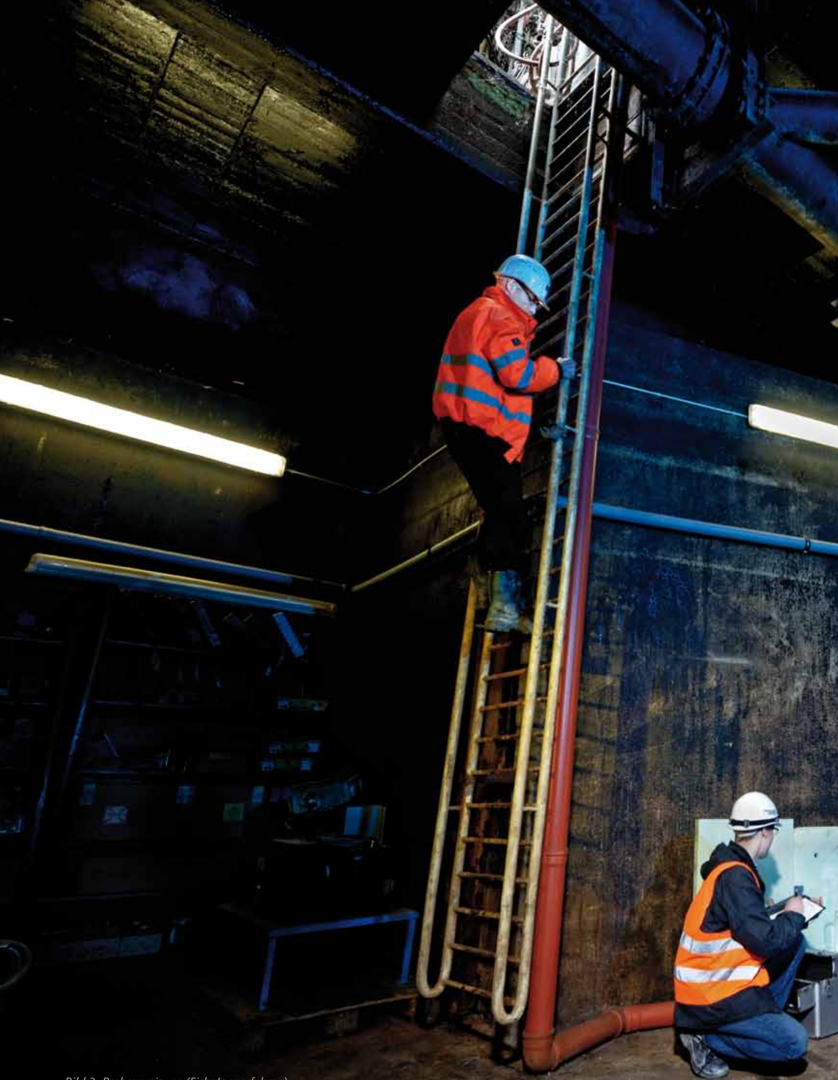
Bild 3: Probevereisung (Eisbetonverfahren) der Schachtwand eines alten Wasserwerkes. Foto: Peter Winandy
