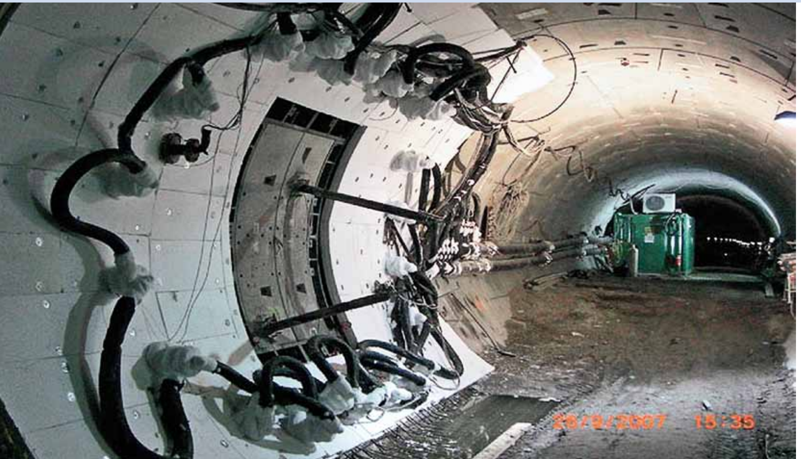
Bild 1: Querschlagvereisung mit mobilen Kühlaggregaten beim Statentunnel in Rotterdam. Quelle: Wenke, Willner (2008): Statentunnel in Rotterdam – Ausführungserfahrungen von Vereisungsbohrungen und der Vereisung von Querschlägen. Geomechanik und Tunnelbau, Nr.1/2008. S. 504-511.
