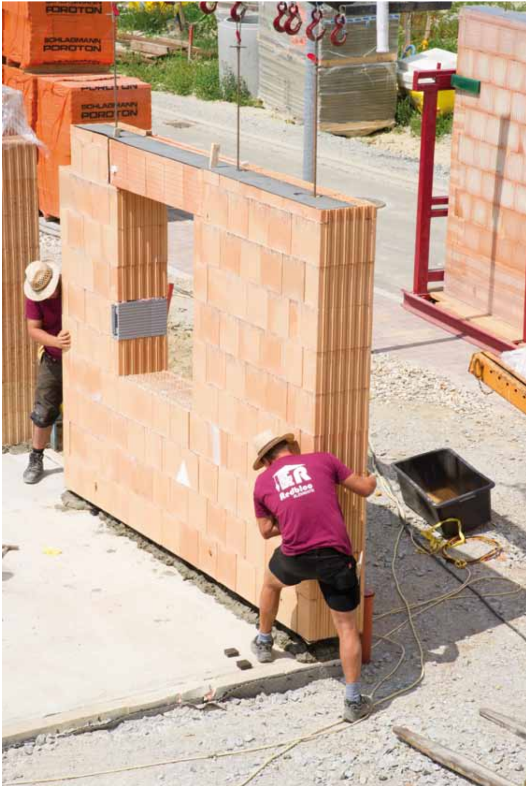
Bild 4: Absetzen der Elemente in ein Mörtelbett. Foto: Redbloc Elemente GmbH
