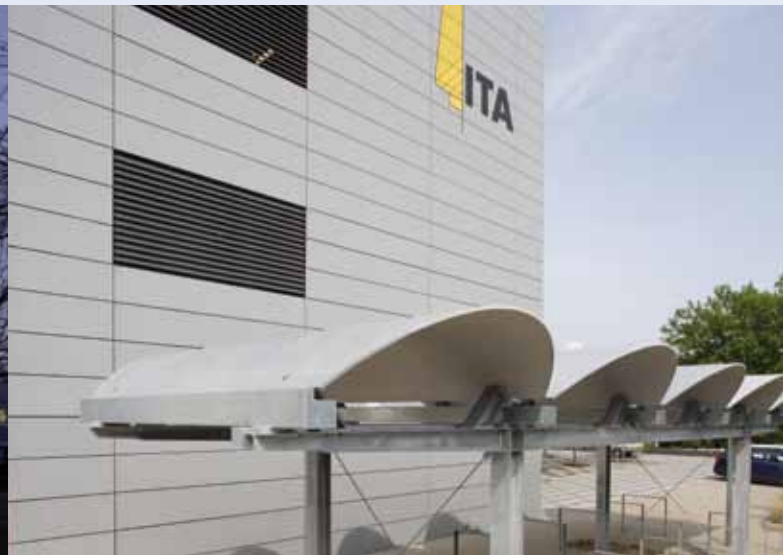
Bild 2: Fertigteile für Textilbeton-Dachelemente am Institut für Textiltechnik der RWTH Aachen. Foto: Robert Mehl
