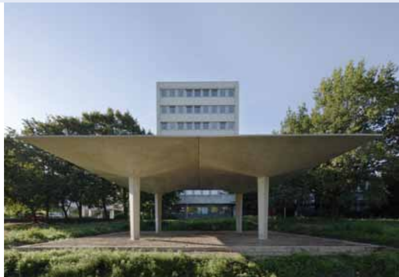
Bild 1: Großformatige Textilbetonschalen des T3-Pavillons in Aachen mit einer Grundform aus hyperbolischen Paraboloiden. Fotos: Robert Mehl
