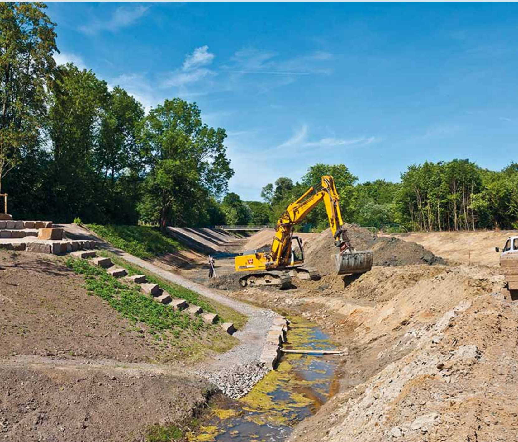
Bild 1: Die ehemals an der Oberfläche verlaufenden Abwasserkanäle werden unter die Erde verlegt und es entstehen renaturierte Fließgewässer, die eine nachhaltige und moderne Umwelt sichern. Maximale Umweltschutzanforderungen während der Bauphase werden durch eine entsprechende Gestaltung des öffentlichen Beschaffungsprozesses ermöglicht. Foto: Jochen Durchleuchter, Emschergenossenschaft
