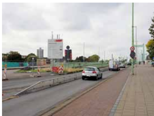
Baustelle Mülheimer Brücke: Die Reduzierung auf eine Kfz-Spur führt zu keinen nennenswerten Beeinträchtigungen für den Autoverkehr.
