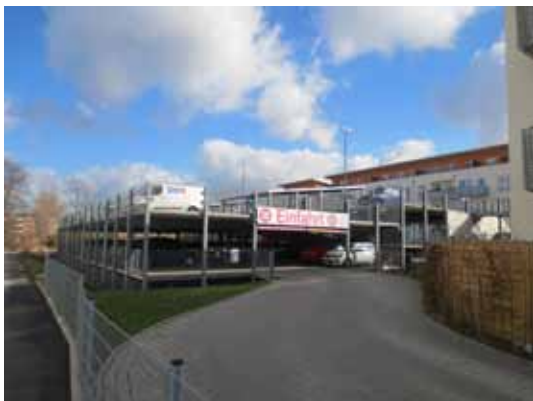
Quartiersgarage in kostengünstiger Hochbauweise bei einer Neubausiedlung in Köln-Nippes
