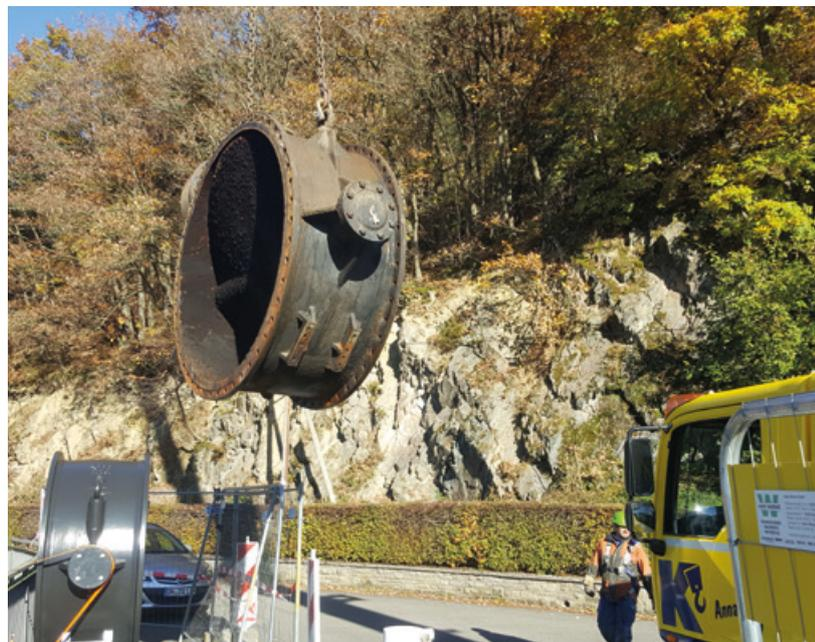
*Abb. links: Der Dammbalkenverschluss des Grundablasses 1 an der Oleftalsperre wird abgelassen*
