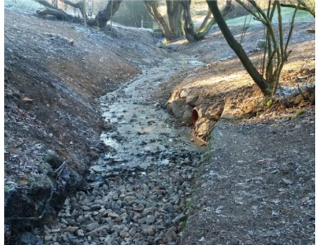
die Ufer abgeflacht und Gefälleunterschiede mit einer Steinschüttung ausgeglichen, um Durchgängigkeitshindernisse für Wasserorganismen zu beseitigen.
