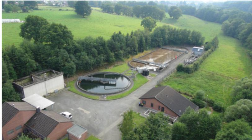
*Kläranlage Roetgen: Die Probenahme erfolgte im Zulauf zum Belebungsbecken (hinten) nach Rechen und Sandfang.*
