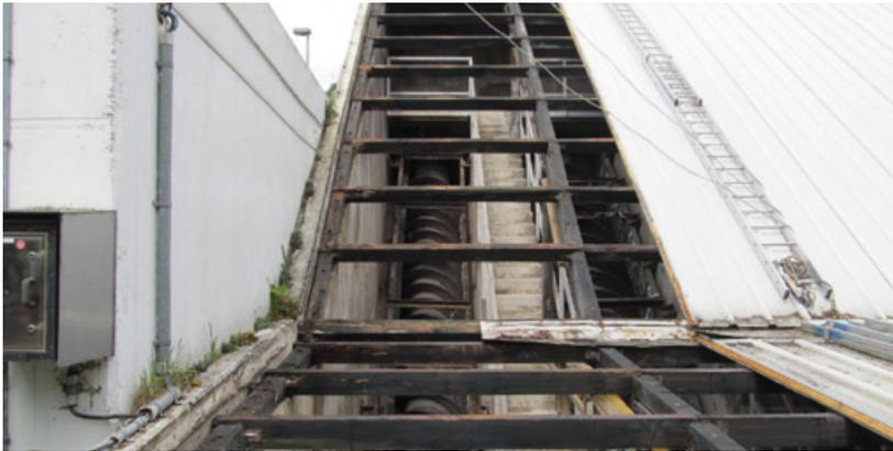
Die GFK-Elemente mit einer Spannweite von 2,50 m bis 3,00 m werden direkt auf die Binder aufgelegt und mit einer außenliegenden Klemmleiste befestigt. Im Bereich der Außenwände des Schneckenpumpwerkes werden die GFK-Elemente auf Stahlprofile aus Edelstahl aufgelegt.
