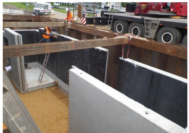
Zeitgleich wurde ein neues Mess- und Probenahmebauwerk zur Erfassung der Abwasserströme der Papierfabrik Schoellershammer errichtet. Im Zuge der Erweiterung der Produktionskapazitäten und des Geländes der Fa. Schoellershammer wurde der Standort des alten Messbauwerkes überbaut. Deshalb musste ein neues Messbauwerk sowie dessen Anbindung an den Hauptsammler 14 errichtet werden.
