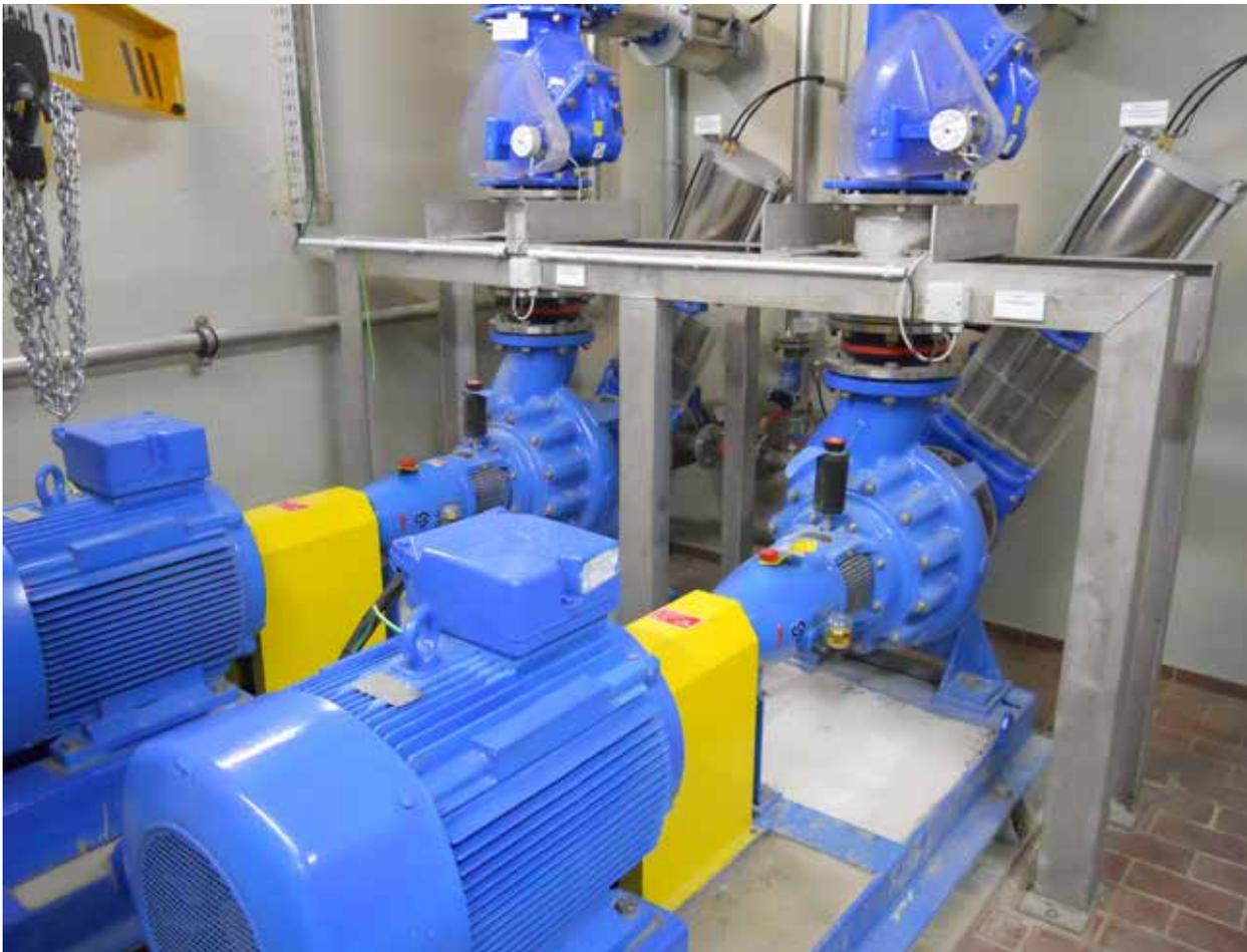
*Neue Trockenwetterpumpen im Pumpwerk des Regenrückhaltebeckens am Adenauerring*
