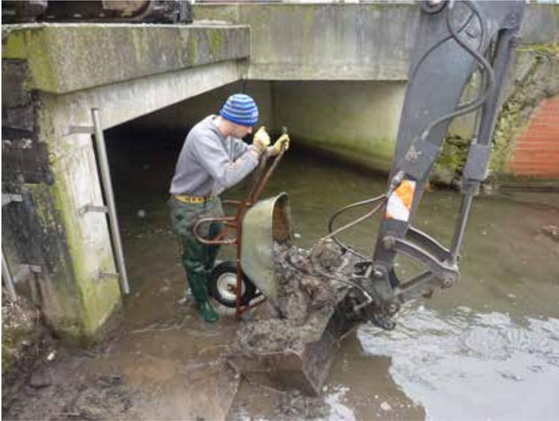
Saug- und Spülfahrzeug einzusetzen, so dass die enge Verrohrung aufwändig von Hand geräumt werden musste. Insbesondere im ersten Abschnitt mussten die Sedimente am Haarener Markt mit Eimern manuell aus der Gewässersohle entfernt werden.
