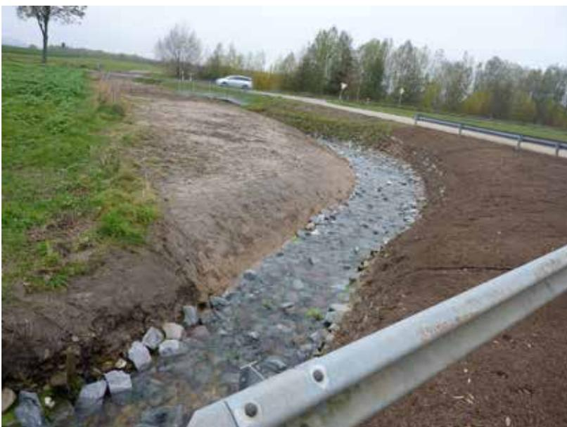
*Ausgespülte und wiederhergestellte Böschung des Schaufenberger Fließes*
