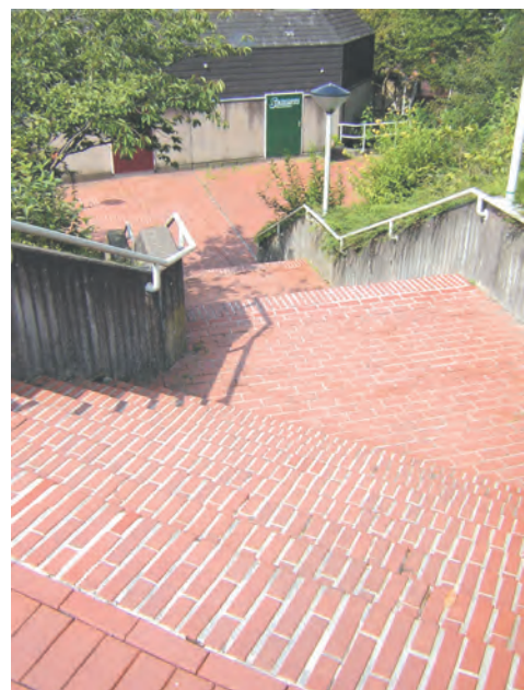
Treppenanlage zwischen Kadettenstraße und Schloßstraße
