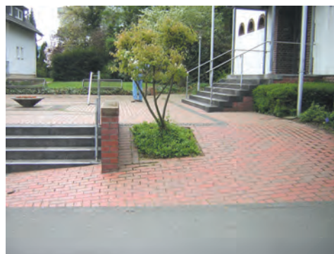
Bild 12: Barrierefreier Zugang Katholische Kirche Untereschbach
