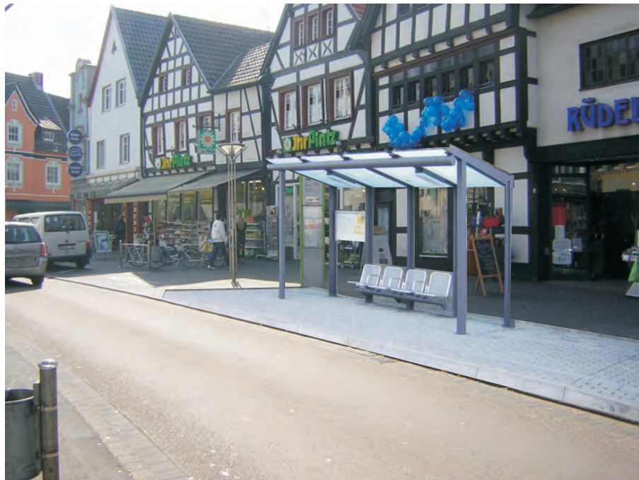
Bild 45: Errichtung einer Wartehalle an der Haltestelle Hauptstr.
