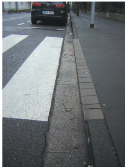
Bild 35: Nahezu niveaugleiche Bordsteinabsenkung
