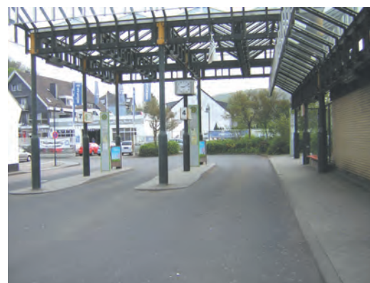
Bild 18: Bussteige Busbahnhof Overath
