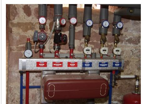
Nahwärmeverteiler im Keller eines Mehrfamilienhauses mit Wärmezählern für die einzelnen Abnehmer
