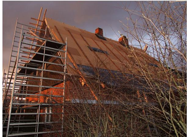
Wärmedämmung eines Hausdachs mit Holzfaserdämmplatten kombiniert mit Einblasdämmung aus Zellulose.
