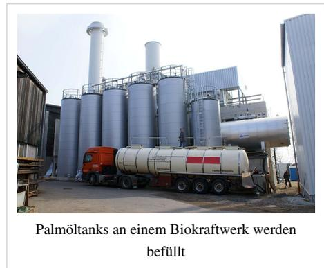
Palmöltanks an einem Biokraftwerk werden befüllt
