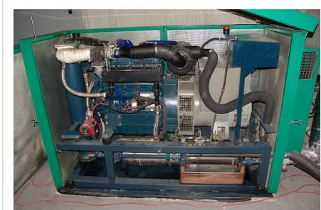
Mini-Blockheizkraftwerk, für den Betrieb mit kaltgepresstem Rapsöl geeignet
