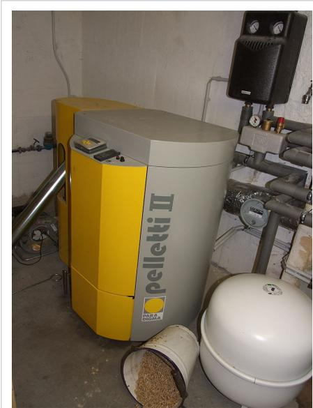
Pelletheizung eines Wohnhauses mit Brennstoffzufuhr über Schnecke (Metallrohr links).
