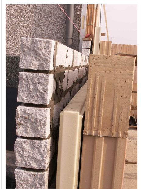
Dämmschicht aus Polyurethan-Hartschaum beim Hausbau
