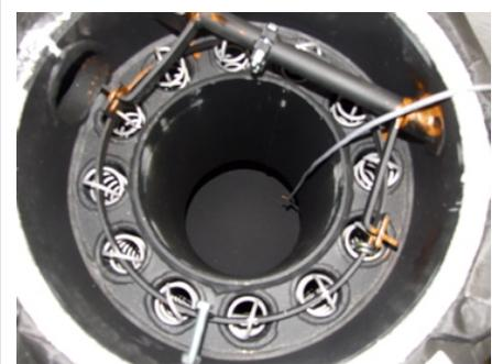
Geöffneter Pelletkessel. Kreisförmig um den Kessel Rauchgaszüge mit automatischer Reinigung per Feder.
