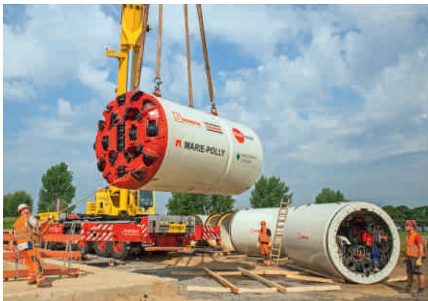
**Bild 5.4:** Marie-Polly am Haken: Nach ihrer feierlichen Taufe wird die Microtunneling-Bohrmaschine vom Typ AVND2000 in die Dükerbaugrube im rechtsrheinischen Poll hinabgelassen.
