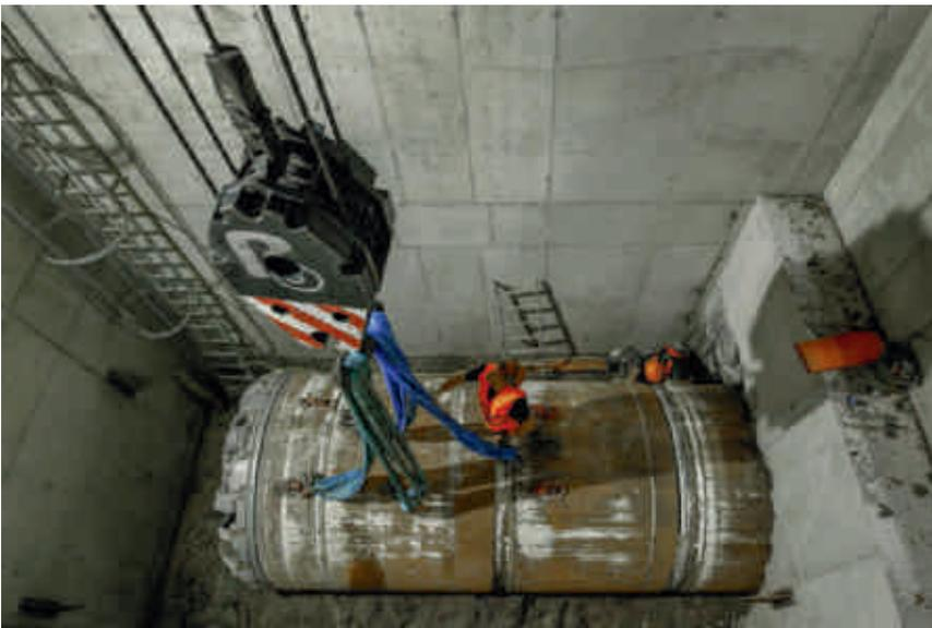
**Bild 5.5:** Angekommen: Nach nur 31 Bohrtagen hat Marie-Polly die Zielgrube im linksrheinischen Köln erreicht. Mit einer Abweichung von weniger als drei Zentimetern von der avisierten Lage brach sie durch die Stirnwand der Zielgrube.
