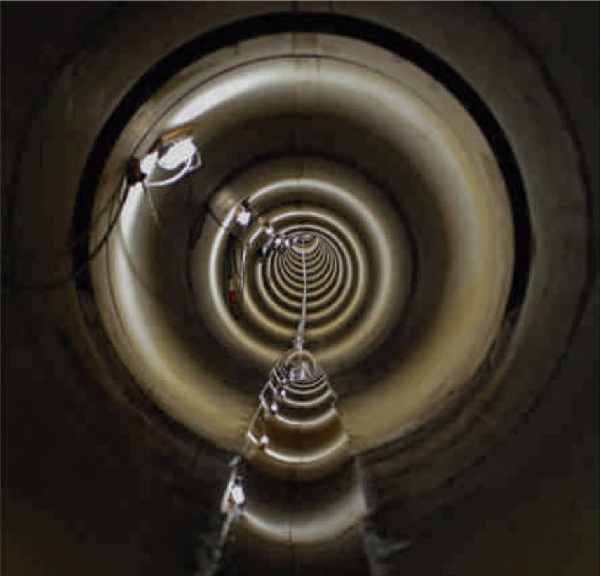
**Bild 5.6:** Blick in die fertige Tunnelröhre. Die Rohrachse des Dükers weist ein Maximalgefälle von 7,8 Prozent auf, die vertikale Raumkurve hat einen Radius von 1.400 Meter. Die Leitungsmontage im Tunnel erfolgt seit August 2018.
