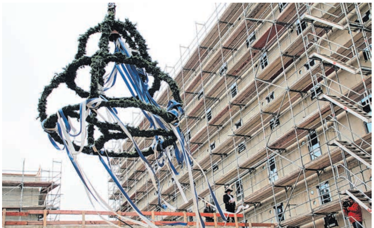
Das Richtfest war ein Meilenstein auf dem Weg zur Eröffnung des Bismarck Quartiers Düren.
