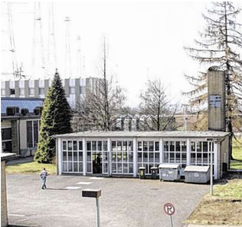
Das ehemalige Gelände der Deutschen Welle: Heute sind die Sendemasten längst abgebaut und das Gebäude wird als Kleiderkammer vom Roten Kreuz genutzt. Fotos: SEG
