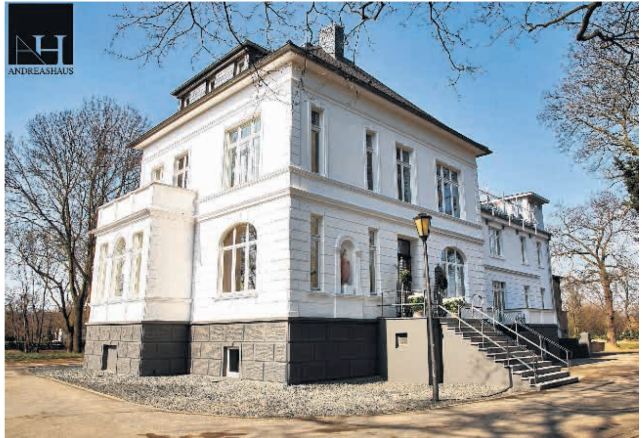
Das Andreashaus in Niederzier wurde in den letzten Jahren aufwändig saniert und modernisiert. Der alte Baustil wurde dabei sowohl innen als auch außen beibehalten. Foto: Peter Blum
