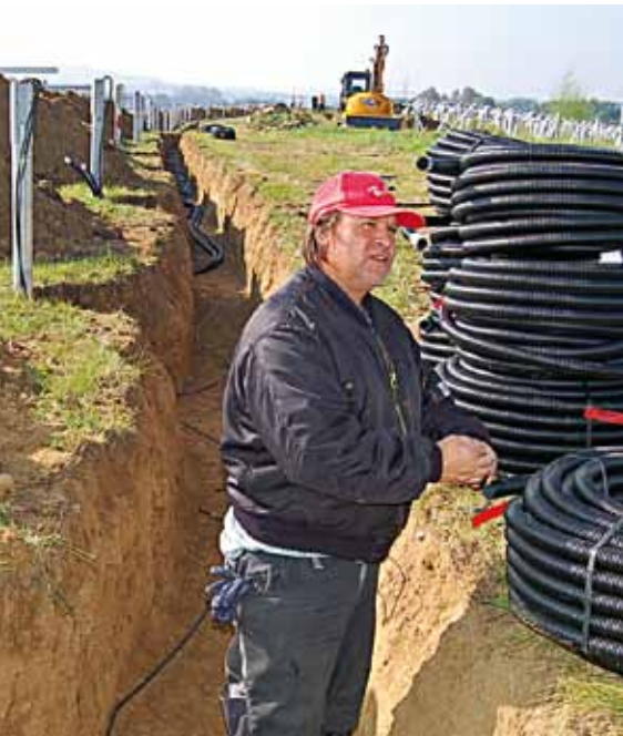
Alle Stromkabel aus den Modulreihen münden in die Hauptleitung.
