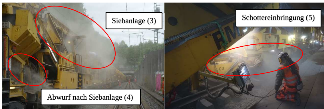
Abbildung 5.3: Siebanlage mit Abwurftrichter und Schottereinbringung
