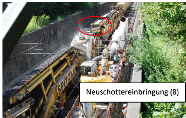
Abbildung 5.5: Neuschottereinbringung
