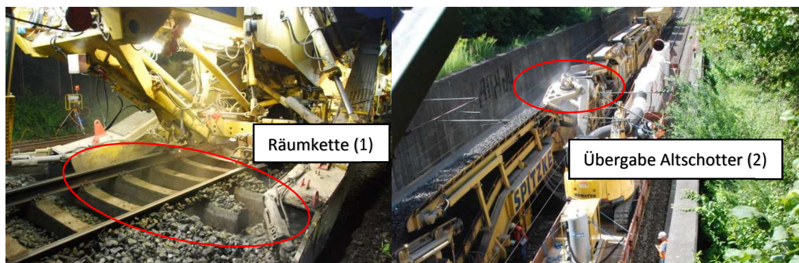
Abbildung 5.2: Aushubbereich der Räumkette & Übergabe Altschotter
