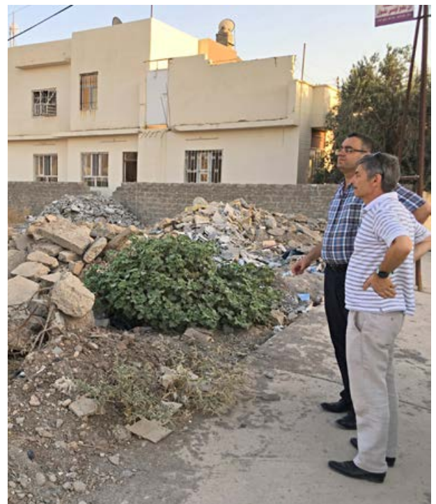
Der von Malteser International unterstützte Wiederaufbau kommt mehr als 30.000 Rückkehrern und Bewohnern zugute.
