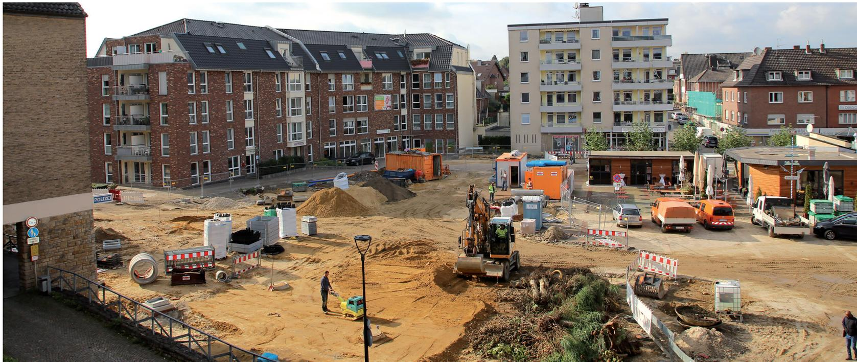
Die Komplexität der Arbeiten zur Entwässerung und den Versorgungsleitungen hat zu einer Verzögerung im vorgesehen Bauablauf geführt. Um diese zeitliche Verschiebung des geplanten Bauzeitendes wieder auszugleichen und weil es aus bau- und verkehrstechnischer Sicht sinnvoll ist, wurde die Planung des Bauablaufs umsortiert.
