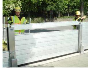
4001 Dammbalken in 377 Stützen eingehängt wurden, die bei einem möglichen Hochwasser der Bevölkerung einen Schutz bis zu einem Wasserstand von 11,30 Meter garantieren. „Wir wollen mit dieser Übung die bereits vorhandenen Fertigkeiten der
