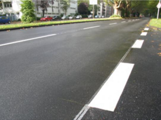
zu verbessern. „Dieser Belag ist einer der leisensten in Europa“, freut sich Carsten Rickers vom Amt für Straßen und Verkehrstechnik, der auch massgeblich an der Entwicklung des neuartigen Asphalts beteiligt war. Bei PKW und LKW wird im Durchschnitt eine Lärmreduzierung von 7 dB(a) erreicht. Unter der Berücksichtigung, dass das menschliche Ohr eine Reduzierung um 3 dB(a) als Halbierung der Lautstärke empfindet, wird der Straßenlärm somit auf cirka ein viertel des bisherigen Wertes gesenkt.
