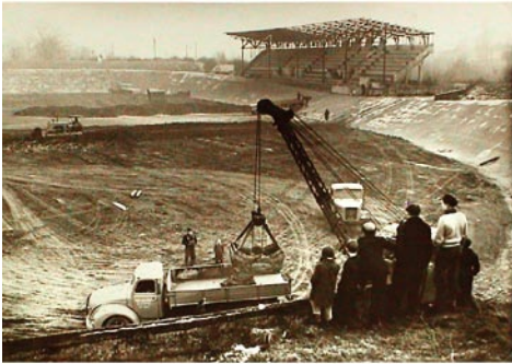
Abriss der Riehler Radrennbahn
