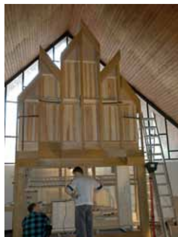
Bau der neuen Orgel in der Gnadenkirche Pech
