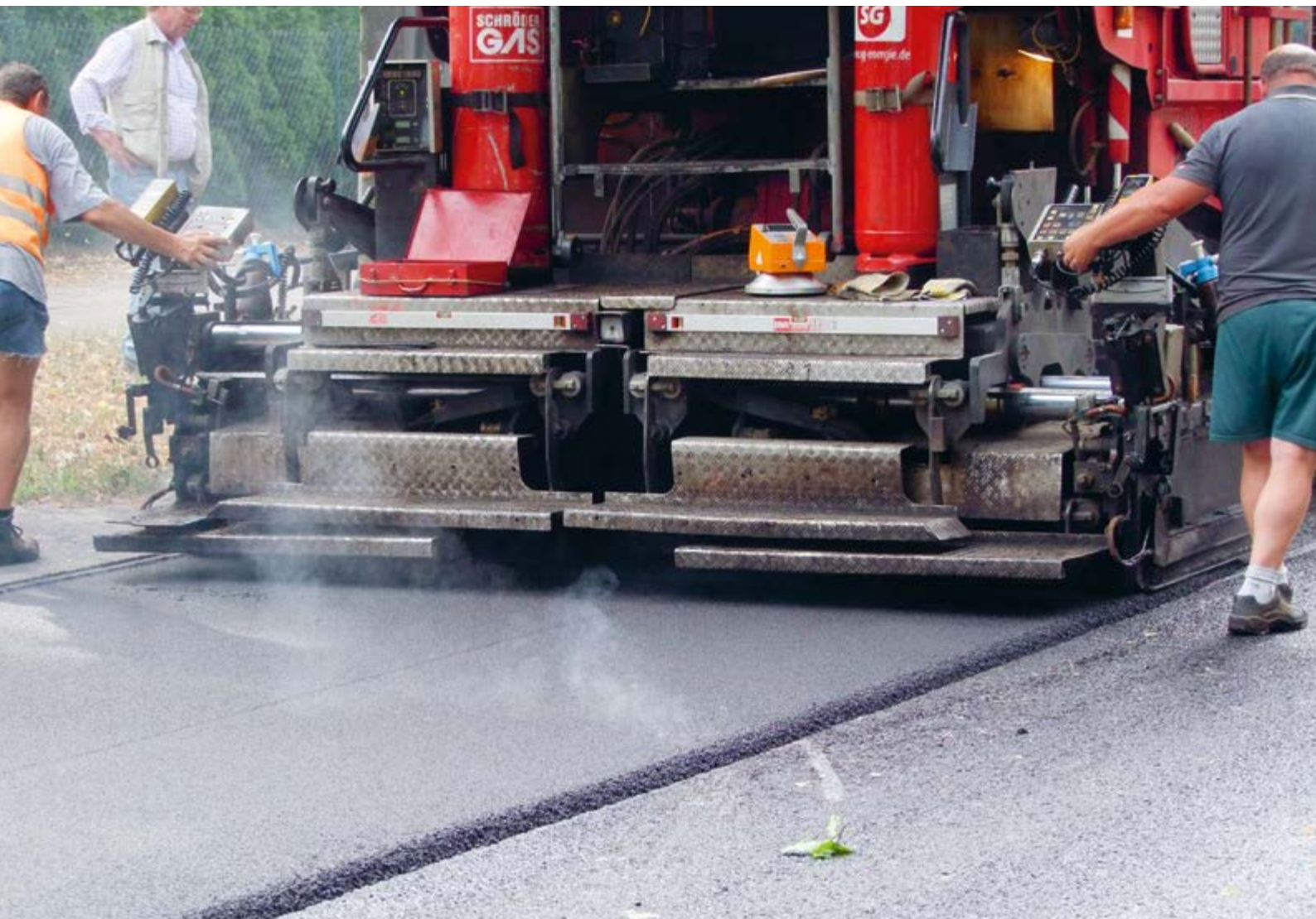
Einbringen eines lärmarmen Fahrbahnbelags
