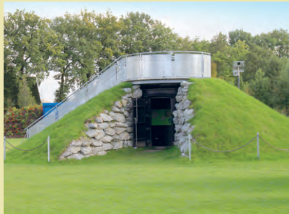
Der Gang durch eine „Abfalldeponie“ veranschaulicht die Gewinnung von Deponiegas
