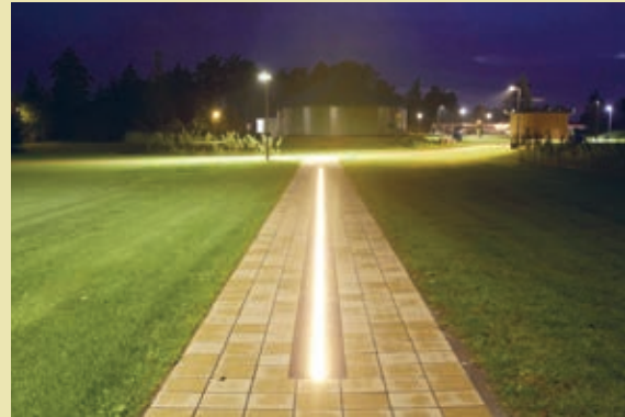
Taktiler Leitstreifen mit LED-Technologie für sehbehinderte Menschen
