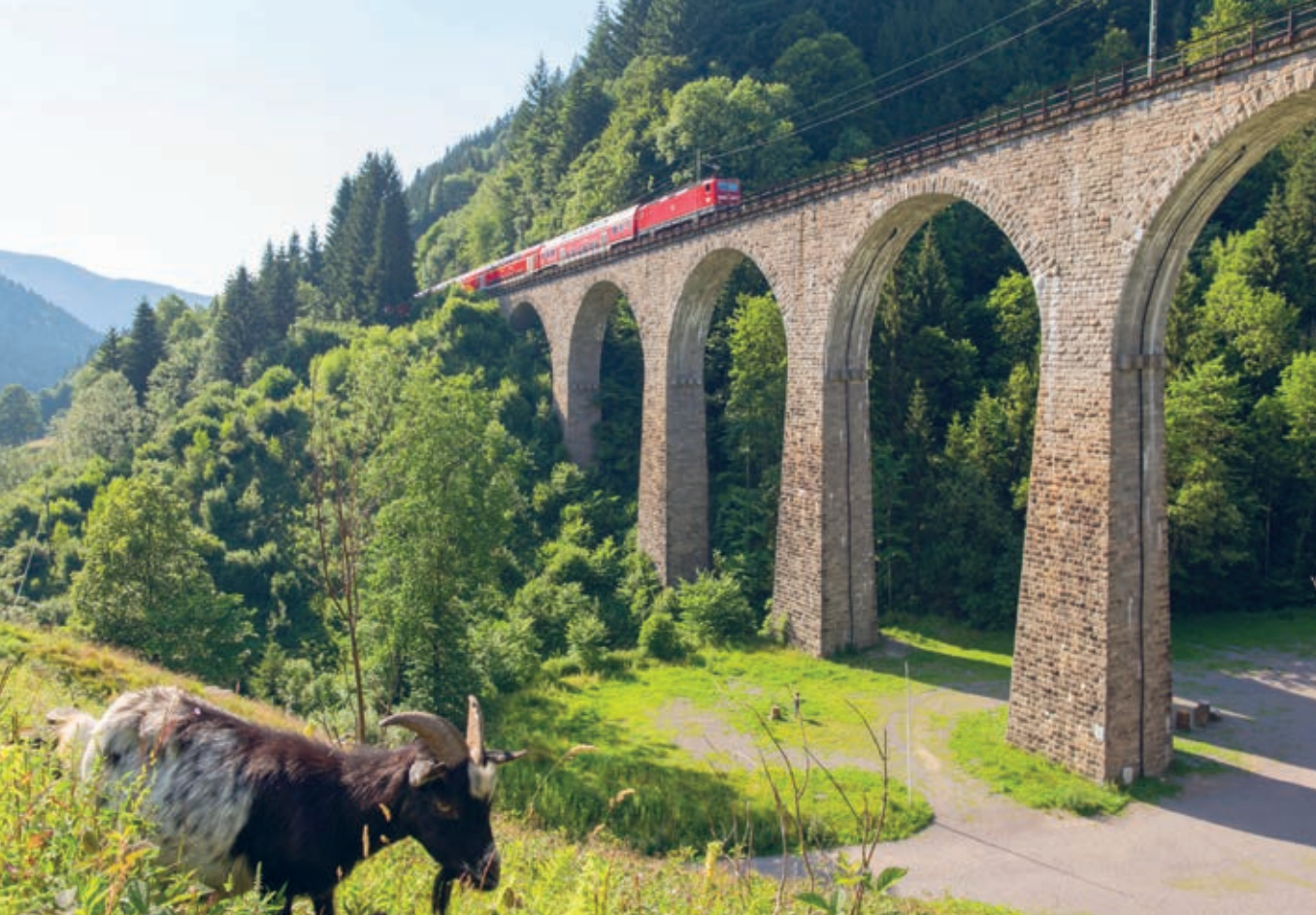
Die Höllentalbahn auf dem Eisenbahnviadukt „Ravennabrücke“
