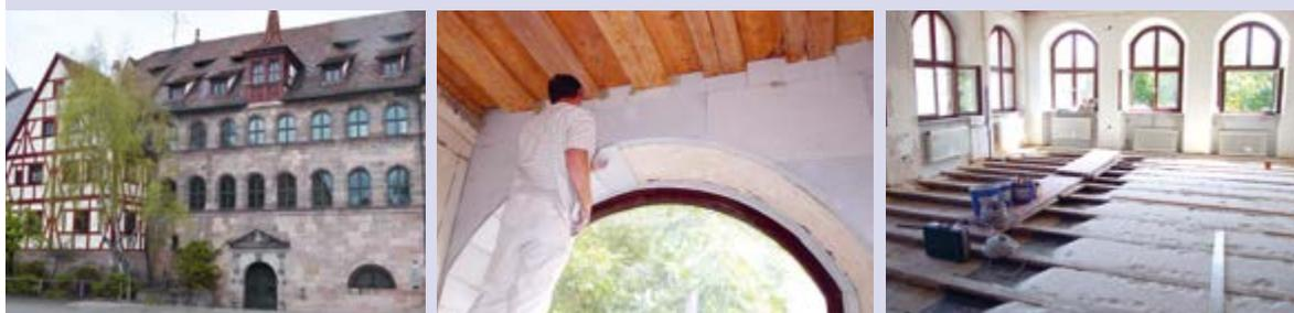
Oben: Herrenschießhaus außen nach Sanierung, Einbau der Innendämmung, Dämmung Boden – unten: Energieverbrauchsentwicklung in kWh/m<sup>2</sup>a (Wärme witterungsbereinigt) vor und nach Sanierung Herrenschießhaus
